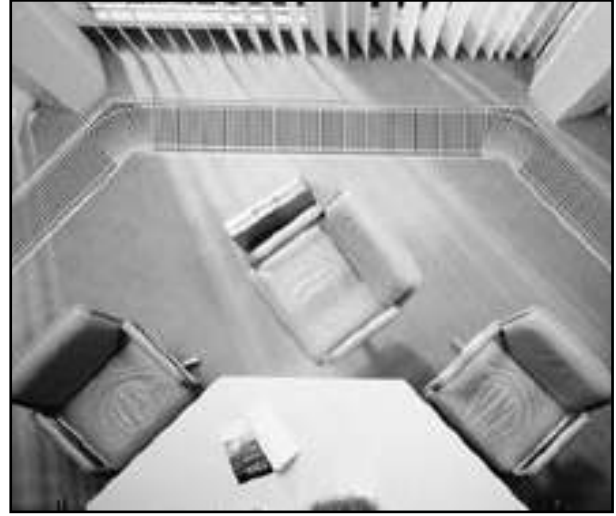
Şekil 268. DÖŞEME TİPİ KONVEKTÖR UYGULAMASI
