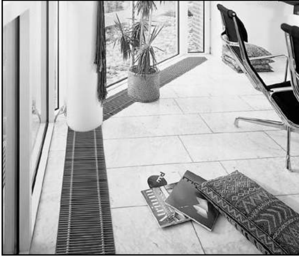
Şekil 267. DÖŞEME TİPİ KONVEKTÖR UYGULAMASI
