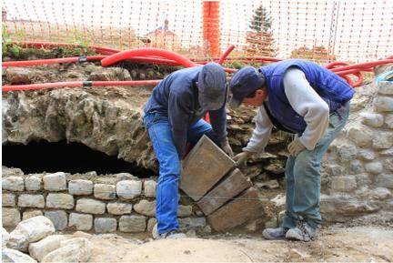
Le parement et la première arche reposent sur une semelle en béton armé.
