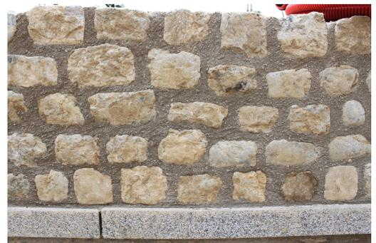
Parapet en pierre de pavage avec la finition joints brossés et plinthe en granit.
