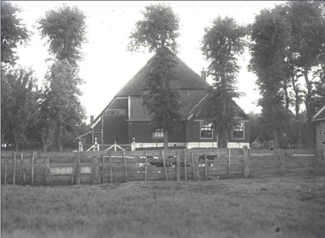
Afbeelding 11. De stolpboerderij in 1921, kort voor het afbreken van de houten voorgevel. De topgevel boven het voorhuis is al verwijderd.
