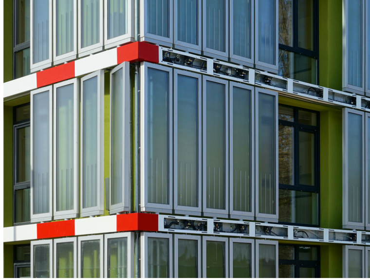
Şekil 20. Bina cephesindeki ikincil fotobiyoreaktör yapısının yakından görünümü [20]
