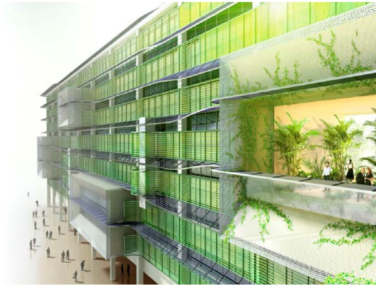
Şekil 12. Tübüler fotobiyoreaktörlerin bina cephesinde uygulanması [26]
