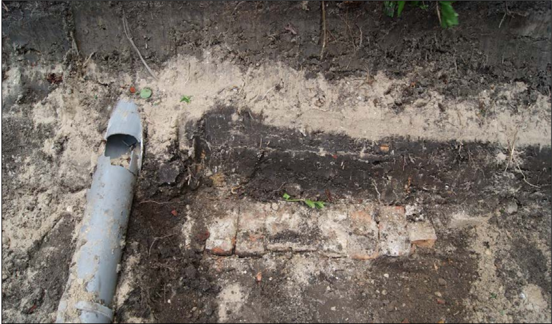
Afb. 7 Fundament in het huis op perceel Achterom 21 (S3), kijkend richting het noorden.
