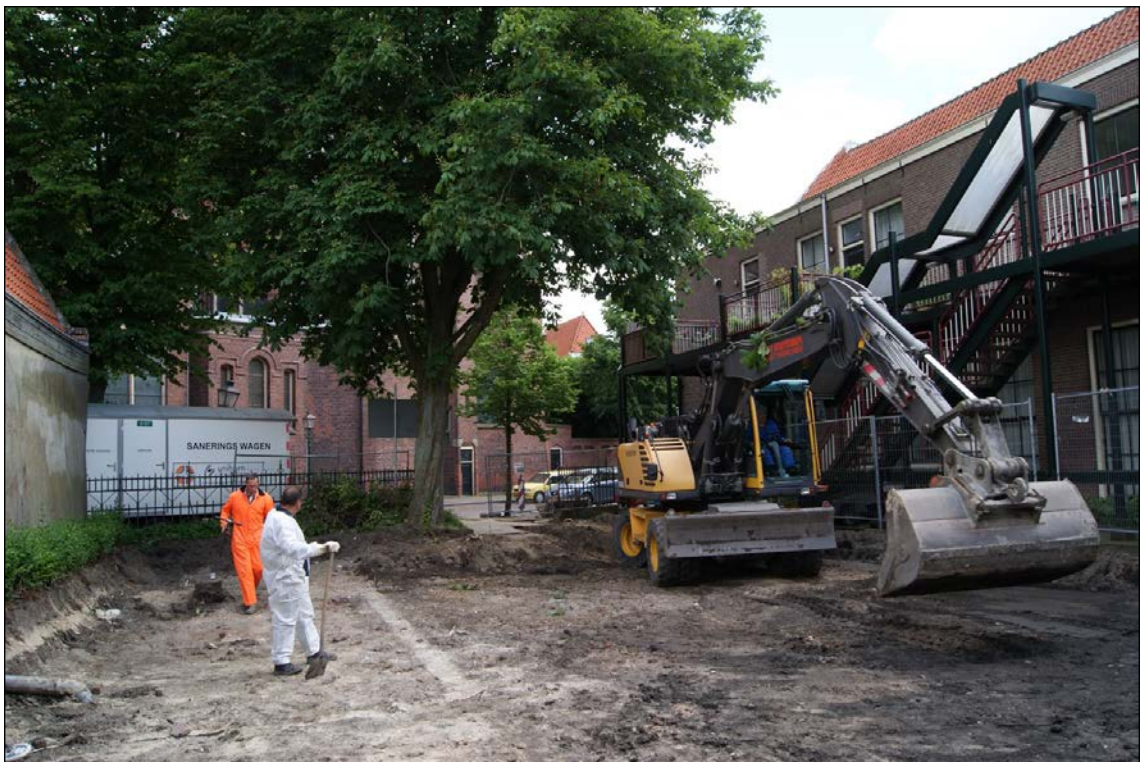
Afb. 1 De sanering van het parkeerterrein van de voormalige St. Jozefschool, gezien richting het oosten. Op de achtergrond tussen de bomen is de Koepelkerk zichtbaar.
