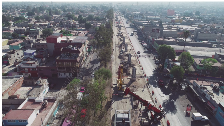
Colocación de estructura metálica.
