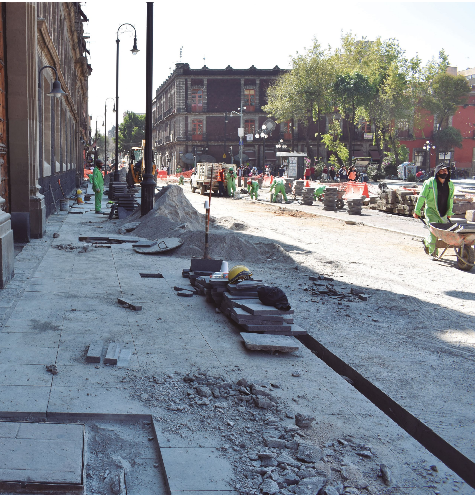
Trabajos de rehabilitación de registros de instalaciones eléctricas en calle Republica de Brasil.
