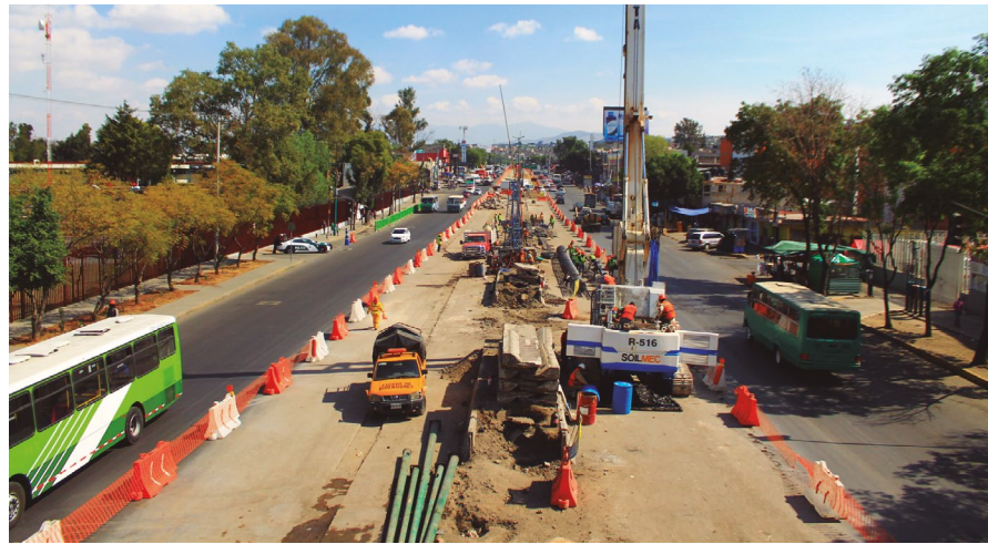
Trabajos preliminares para construcción de cimentación.
