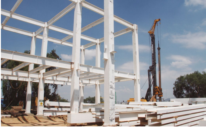
Trabajos de habilitación de estructura metálica.
