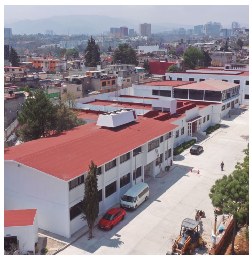
Vista general de la construcción de la Universidad de la Salud.
