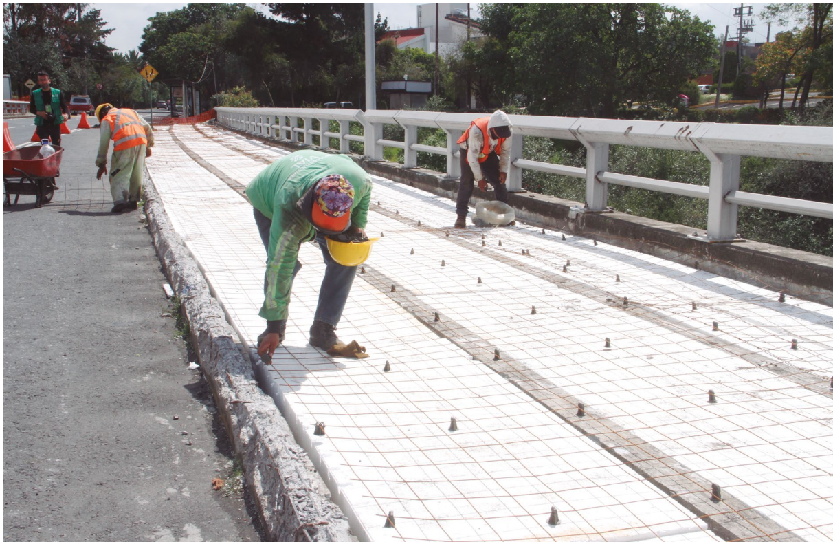
Trabajos de rehabilitación de superficie de rodamiento.
