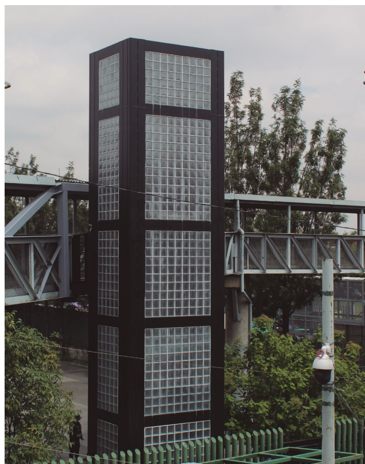
Construcción de elevador para la movilidad universal.
