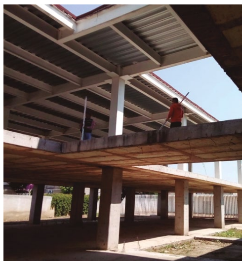
Edificación a base de estructura metálica y de concreto.
