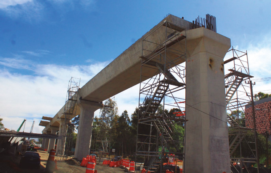
Montaje de traveses prefabricadas de concreto reforzado.
