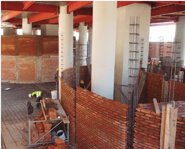
Estación La Pastora. Construcción de muros interiores de estación.
