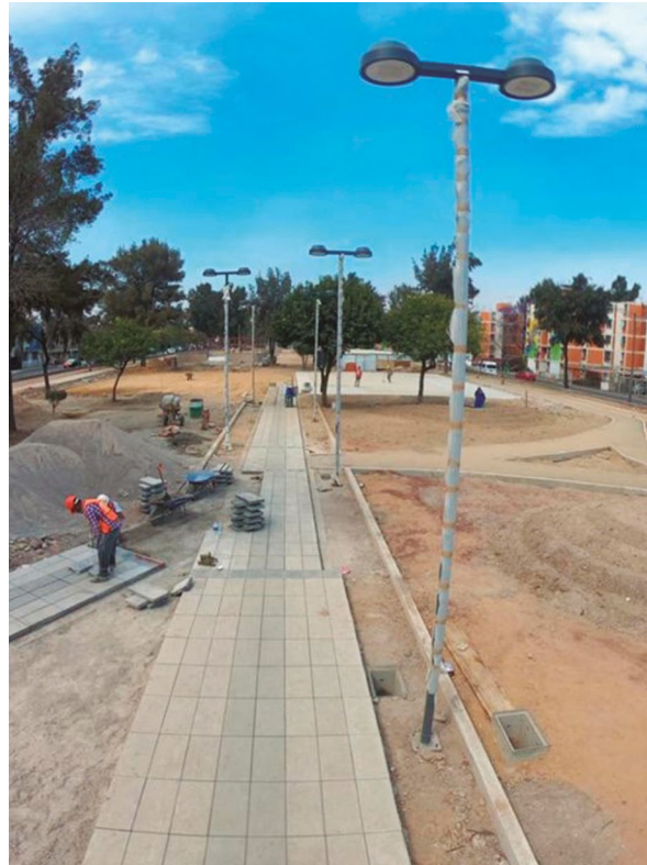
Colocación de banqueta a base de adoquín.
