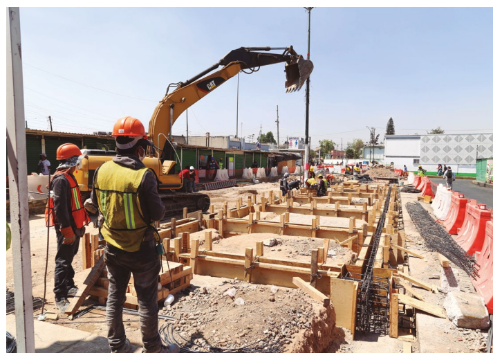
Cimbrado de estación interior CETRAM.
