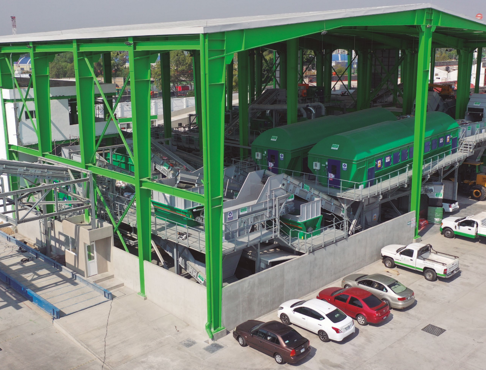
Instalación interior en la Planta de selección.
