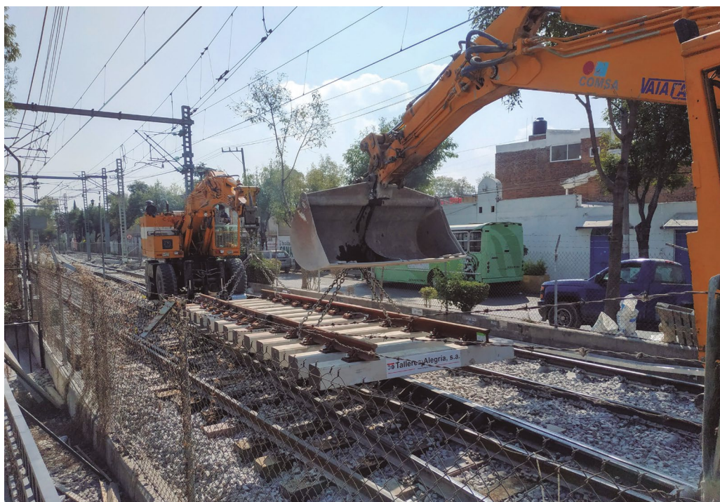
Mantenimiento de vías al Tren Ligero.
