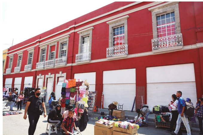
Se muestran la fachada del predio Republica de Argentina número 87, el cual forma parte de los 18 predios que fueron, serán o se encuentra en proceso de atención a través del Programa Especial de Vivienda en Centro Histórico.
