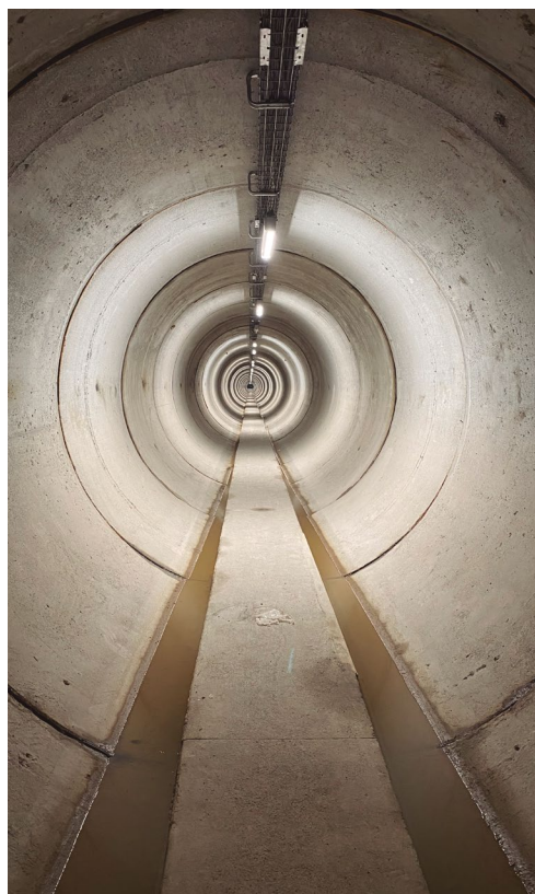
Modernización del Sistema de Transporte Colectivo Metro .
