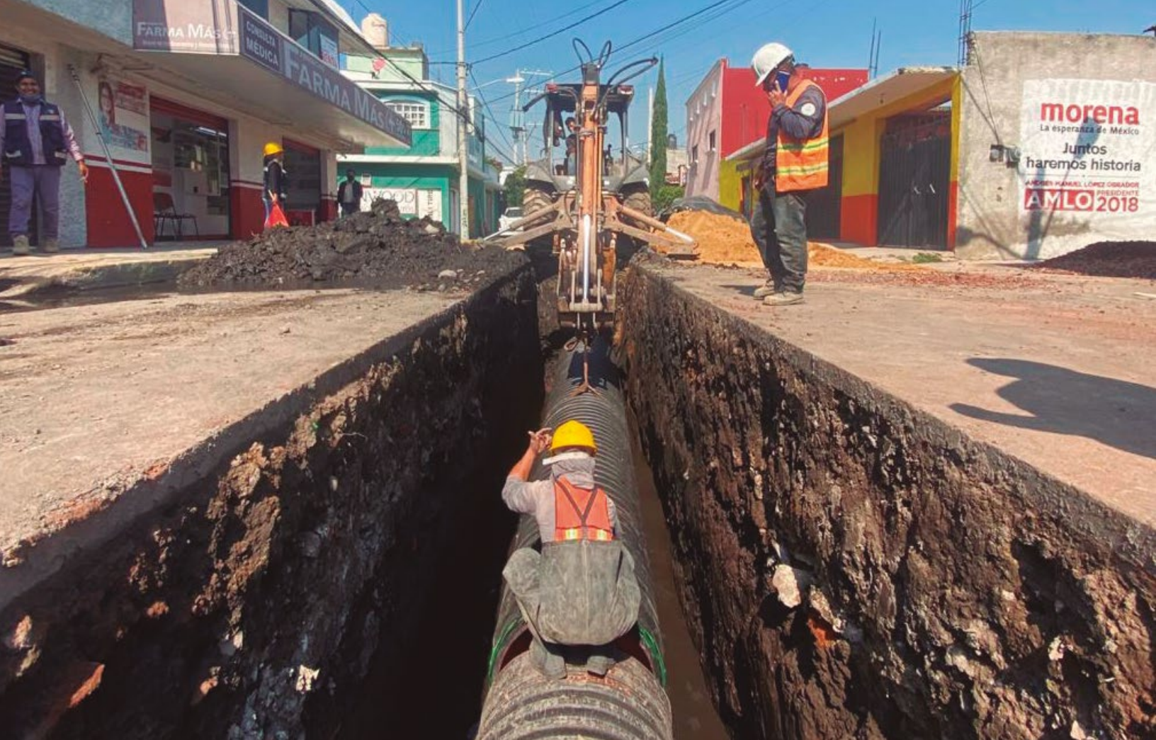
Instalación de tubería de drenaje 0.76 m de diámetro en Colonia la Cebada.
