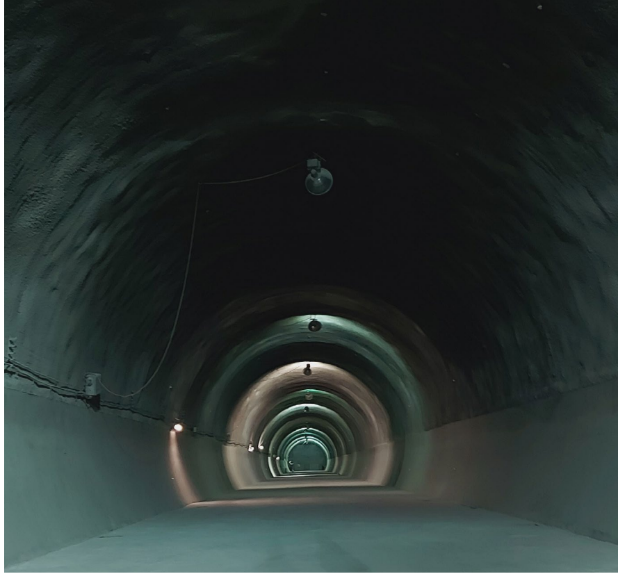
Lumbrera Poniente 83 Muros de Túnel.
