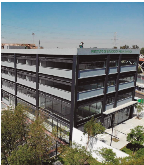
Vista general de la Preparatoria ubicada en el Cetram de Constitución de 1917.
