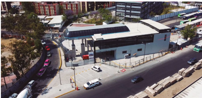
Estación Constitución 1917. Proceso del montaje de elevadores.
