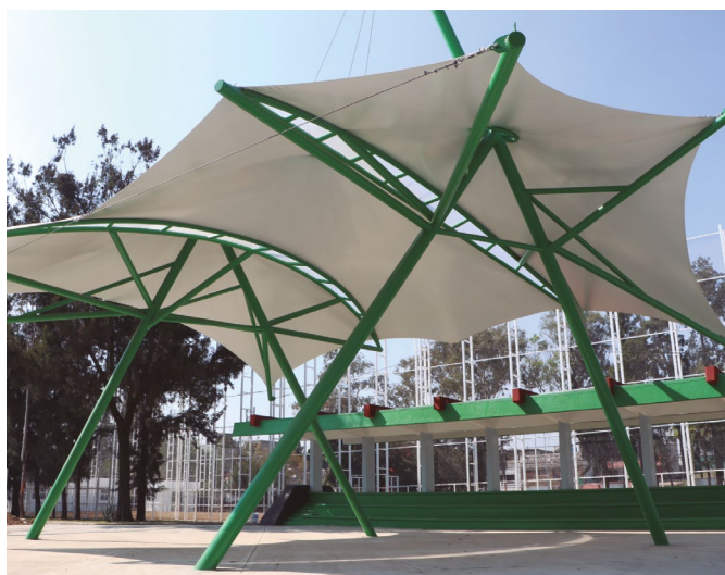
Colocación de velaría arquitectónica.
