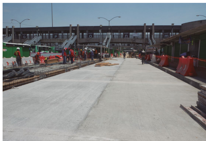
Cimbrado de estación interior CETRAM.
