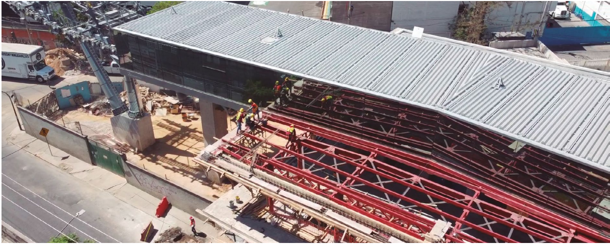
Estación La Pastora. Trabajos de cubierta y fachadas.
