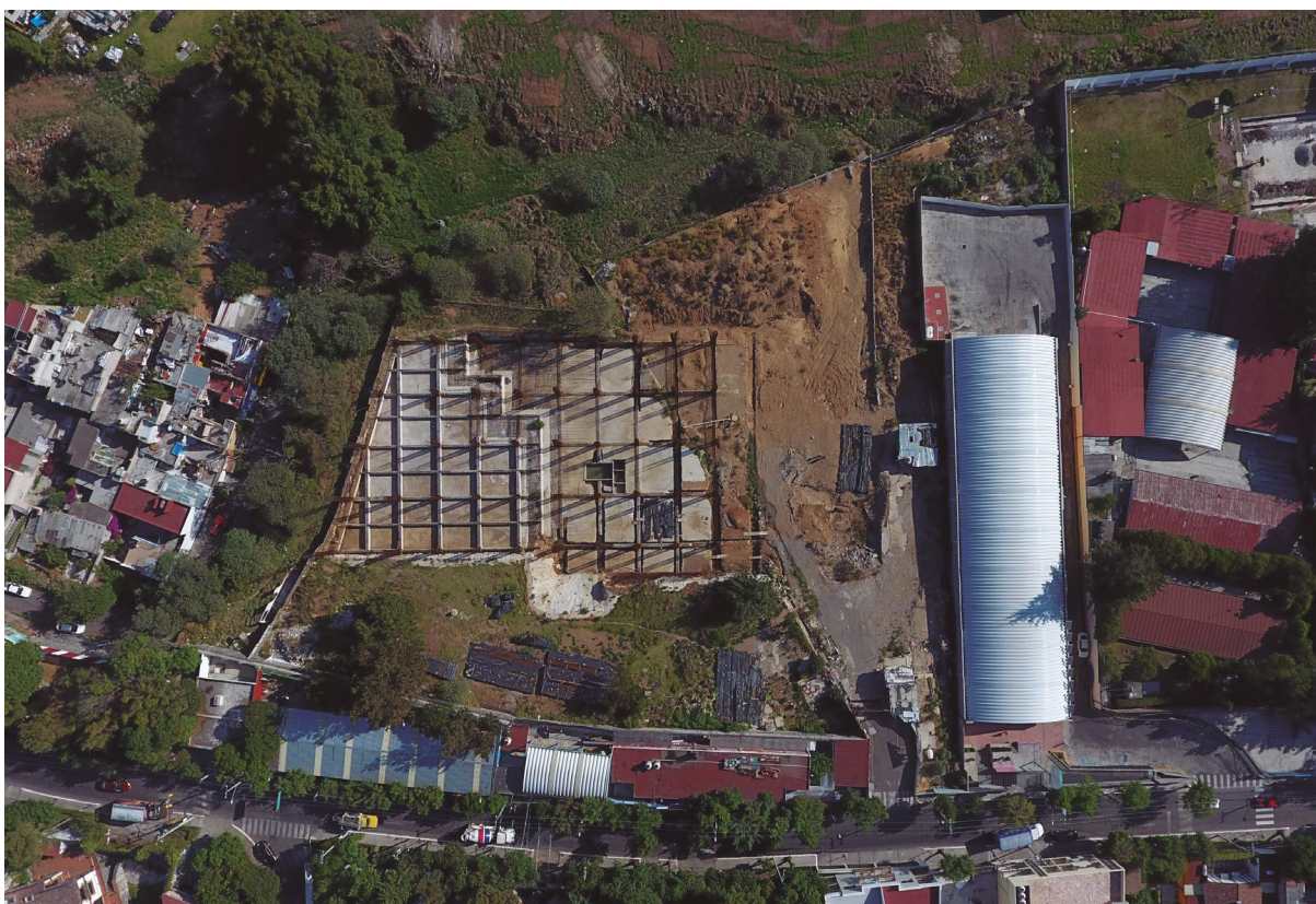
Vista aérea de trabajos de construcción de cimentación.
