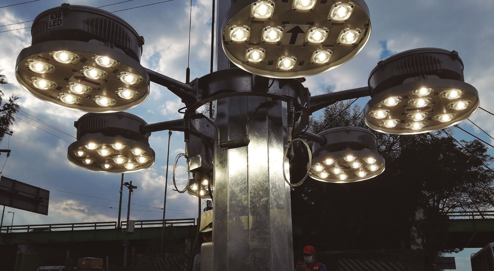
Mantenimiento a superpostes en calzada Ignacio Zaragoza.
