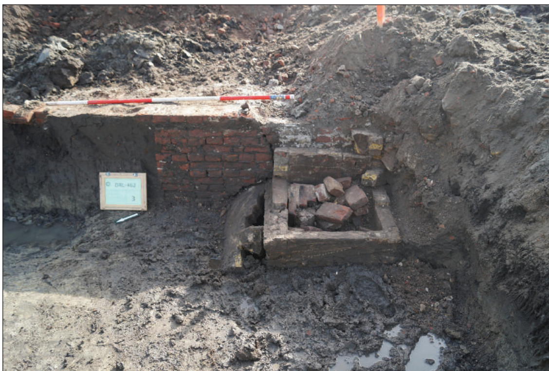
Afb. 34. Fundering S9 is direct op het gewelf van waterkelder S10 geplaatst.
