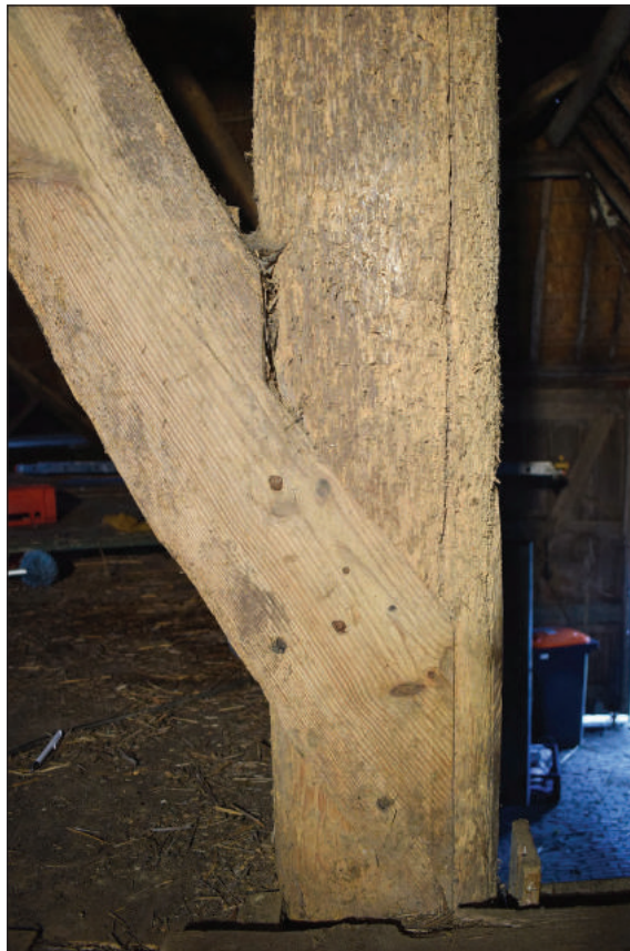
Afb. 27. Verbinding tussen een stijl en zwing.
