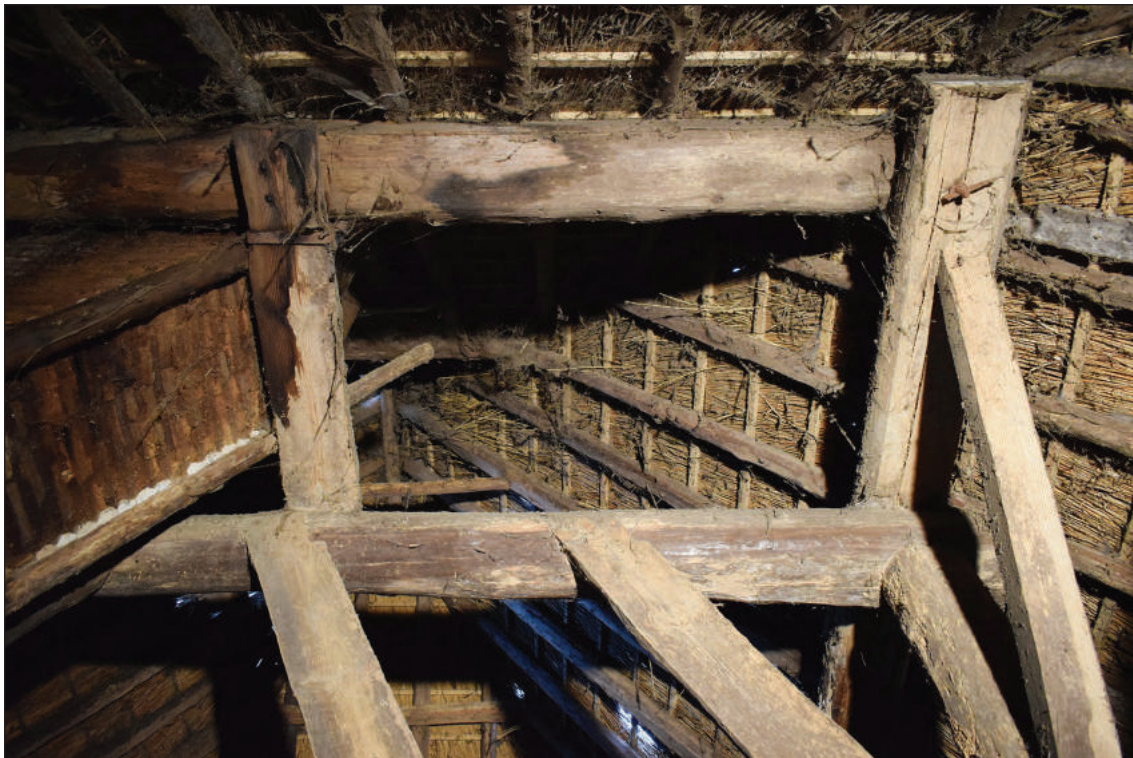
Afb. 26. De overstek van onder gezien. Rechts is een ijzeren spiebout zichtbaar als verbinding tussen de bovenbalk en overstekbalk.
