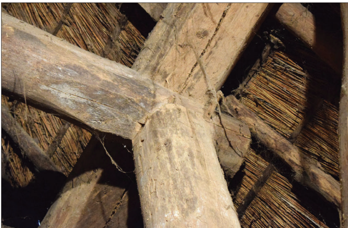
Afb. 25. Verbinding tussen een stijl en dekbalk, en daarop een bovenbalk.
