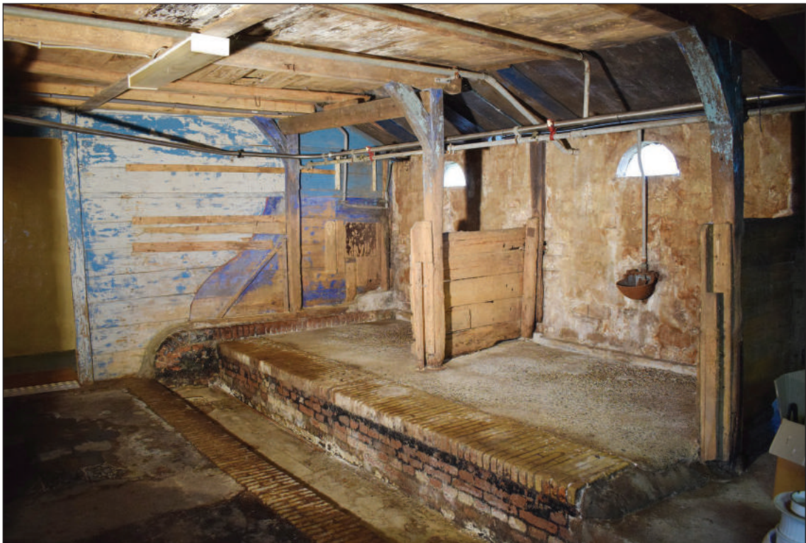
Afb. 20. Noordoosthoek van de stal. De stal werd oorspronkelijk aan de noordzijde begrensd door een lage houten wand met s-vorm. Later is dit een volledige houten wand geworden.
