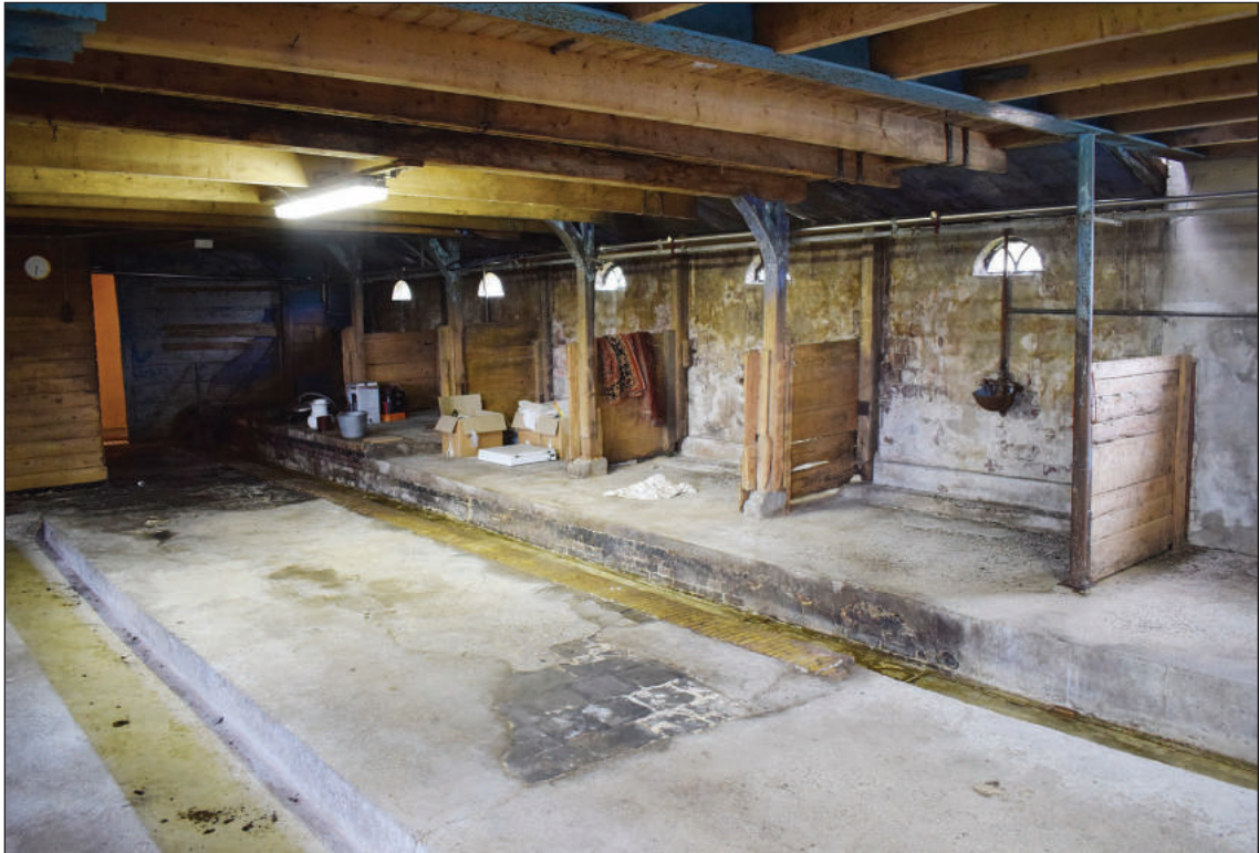
Afb. 19. De koeienstal, gezien richting het oosten. Links vier houten koestijlen, rechts één moderne metalen koestijl.
