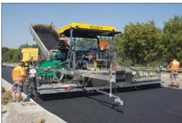
Su ancho de trabajo es, lógicamente, variable con la máquina, pero hay unidades de ancho mínimo, aptas para carril bici, hasta las mayores, capaces de extender anchos superiores a 10 m.
