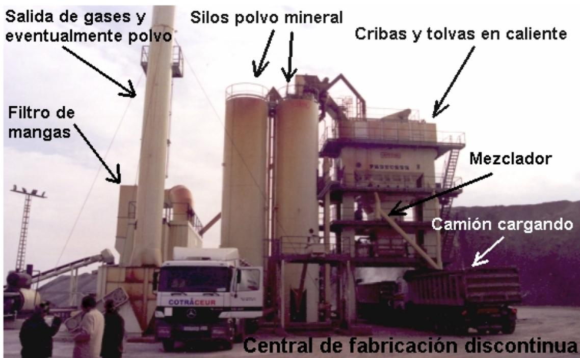
d. Sistema de clasificación de áridos en caliente, A la salida del tambor secador, los áridos vuelven a cribarse y se clasifican por los tamaños retenidos en cada una de las cribas
