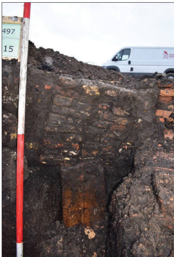
Afb. 26. De koestijl S12 was gefundeerd op een houten paal en sterk richting het westen weggezakt.
