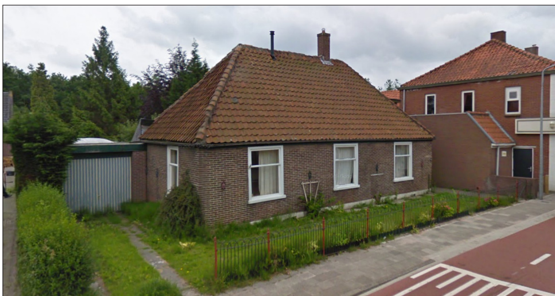
2. Foto Westerblokker 74 voor de afbraak in 2011 (bron: Google Streetview)
