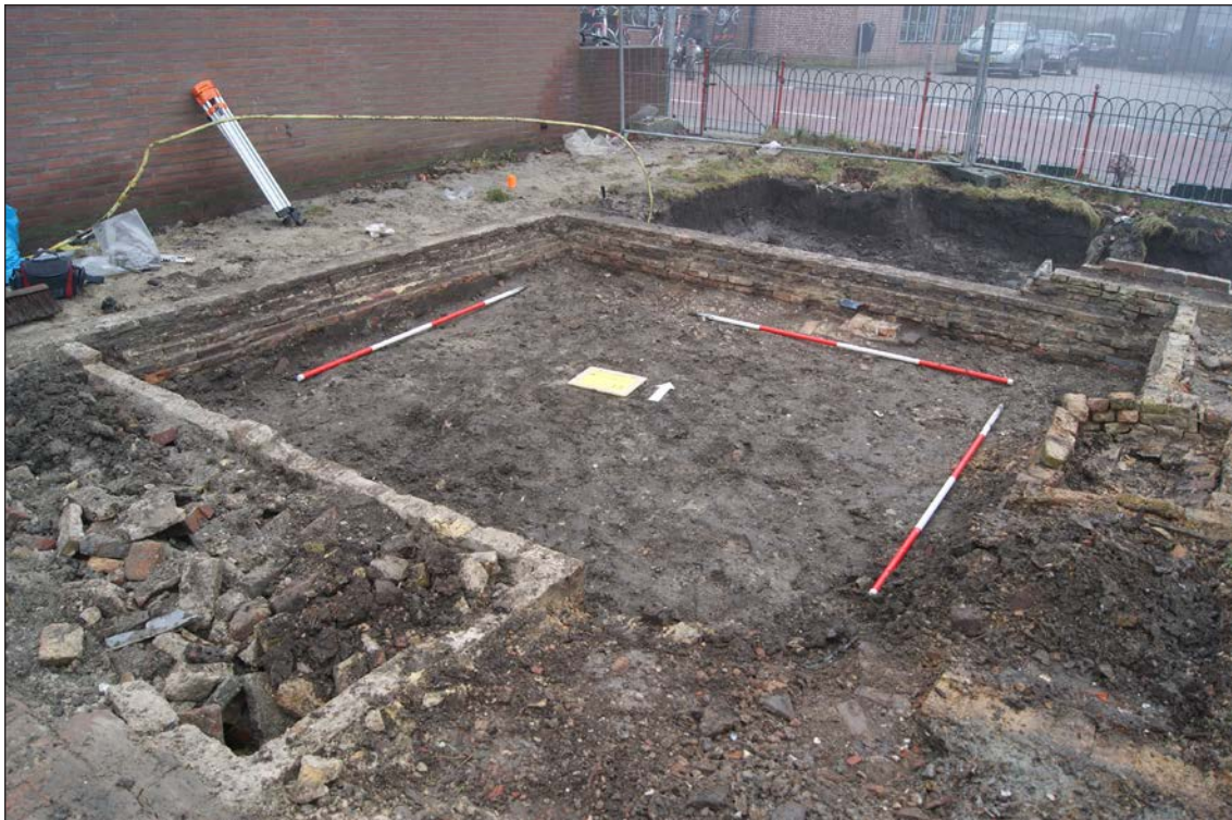
41. De funderingen van de westelijke kamer van het Armenhuis met op de voorgrond de met puin dichtgegooide kelder S10
