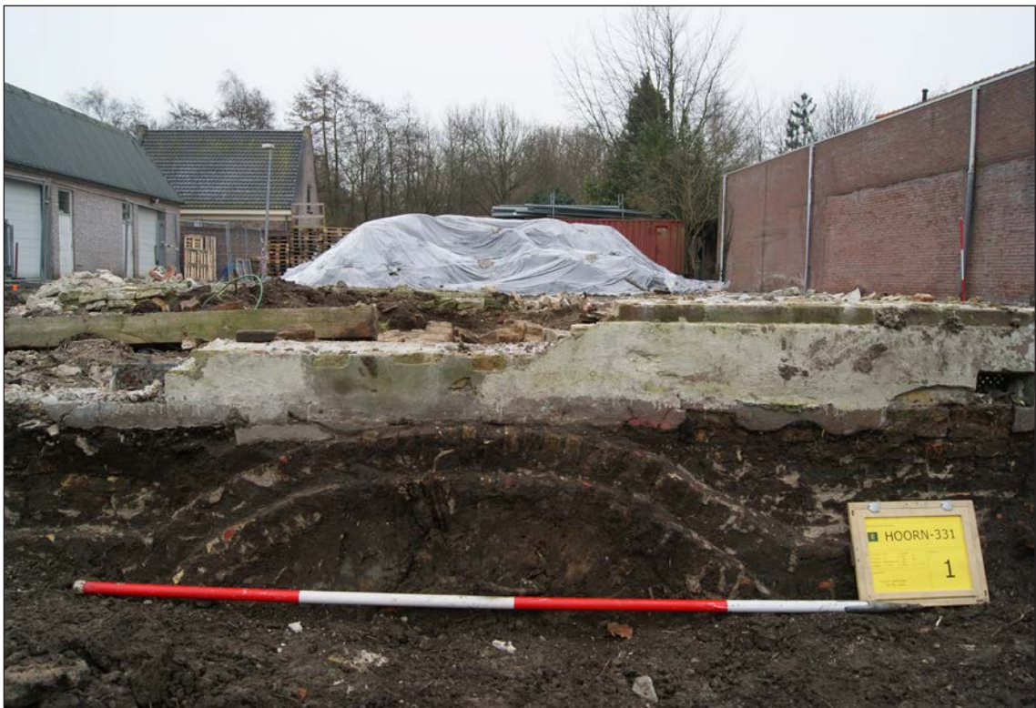
40. De spaarboog in het fundament S01 van de voorgevel van het Armenhuis, kijkend richting het zuiden. Onder de spaarboog bevindt zich de gedempte waterput S37.
