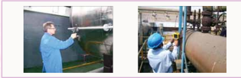
Şekil 11.1. Buhar sistemi değerlendirmesinde termal kameranın kullanımı
