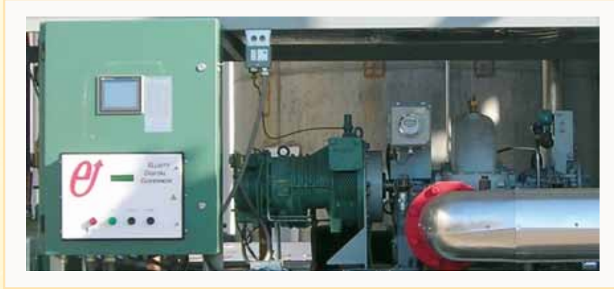
Şekil 13.1. Buhar türbini ile tahrik edilen vidalı soğutucu
