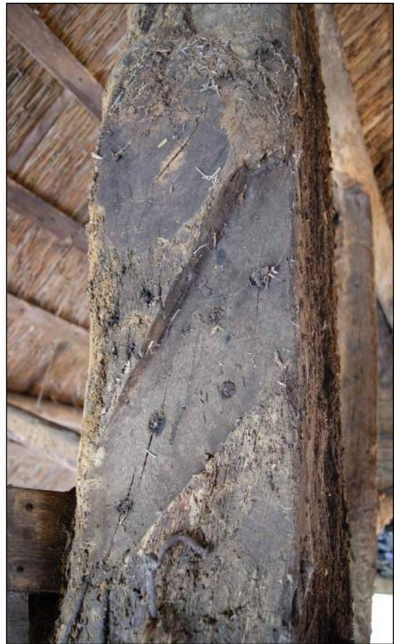
Afb. 92 Inkeping met hak van een verdwenen zwing in de zuidoostelijke stijl.
