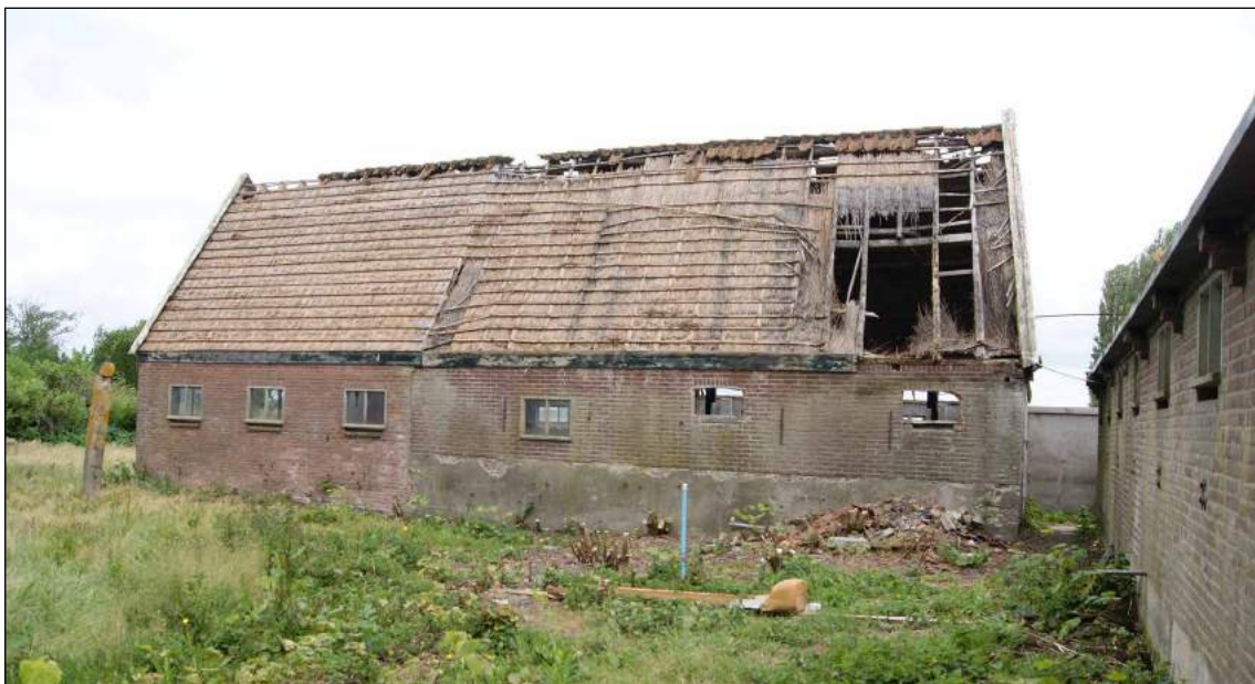
Afb. 71 De schuur schuin achter de boerderij. In het metselwerk zijn twee bouwfasen herkenbaar.
