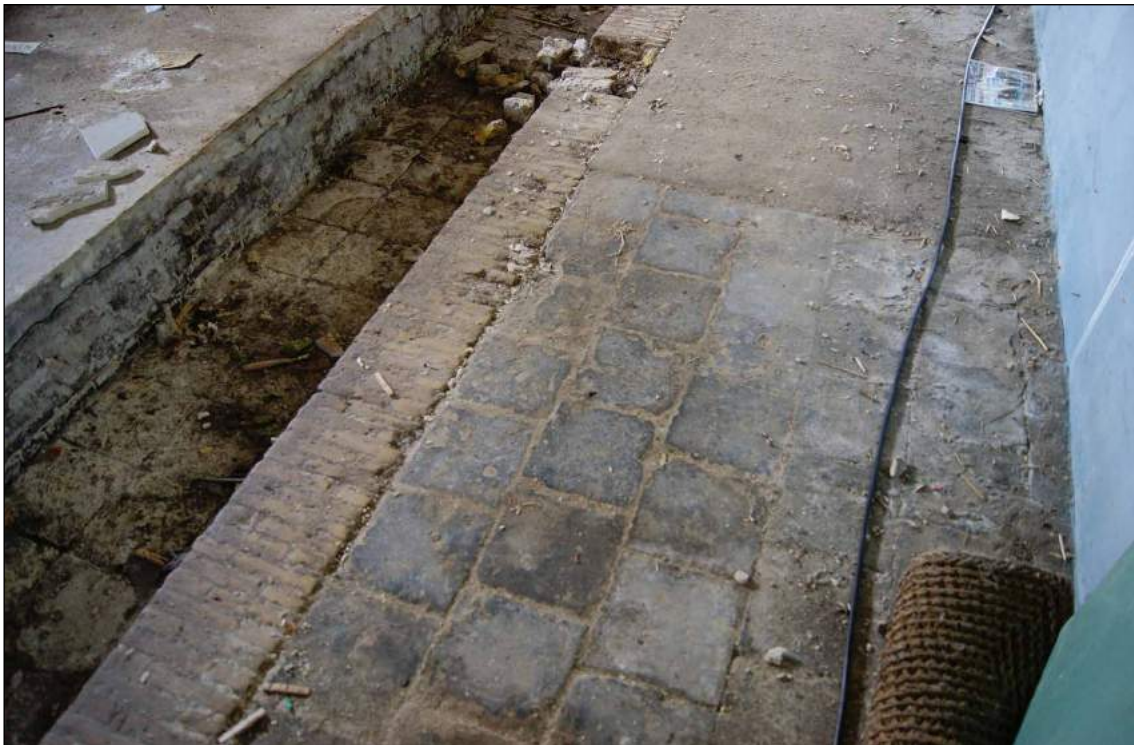
Afb. 66 Grijze plavuizen in het looppad en de mestgoot.
