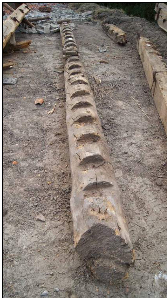
Afb. 88 De ronde overstekbalk aan de westzijde. In de kleine inkepingen lagen de daksparren.
