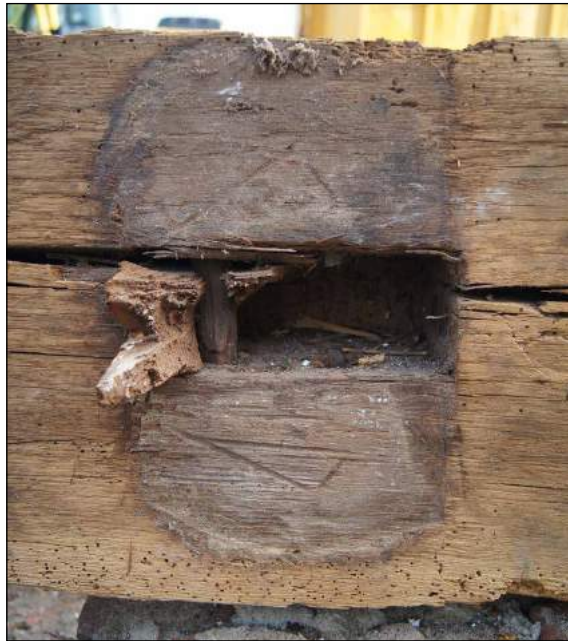
Afb. 77 Rechthoekig pengat in de onderkant van een dekbalk. Op deze plek is tevens een handelsmerk zichtbaar.
