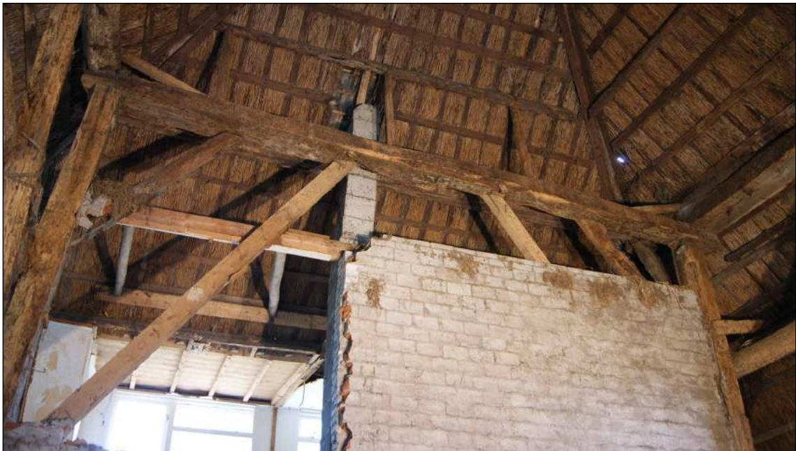
Afb. 79 De dekbalk aan de westkant. Erachter het moderne schoorsteenkanaal van de haard in de woonkamer.
