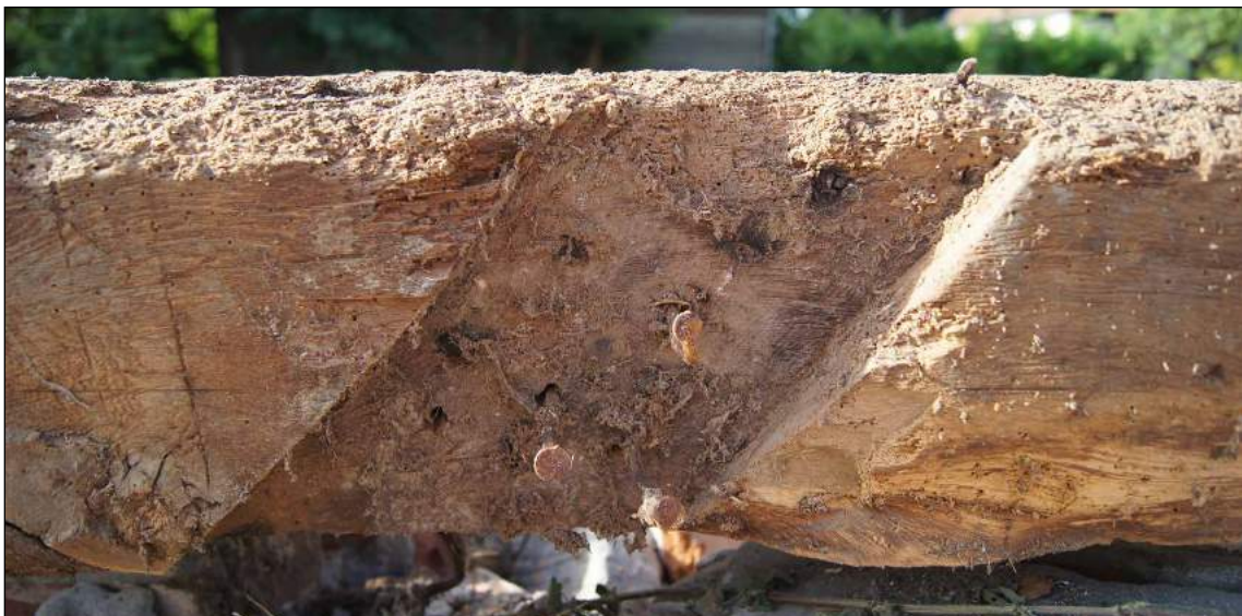
Afb. 93 Inkeping zonder hak van een zwing in de westelijke dekbalk.
