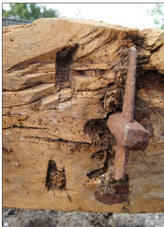
Afb. 85 Twee vlotgaten in de oostkop van de noordelijke bovenbalk. In een van de gaten zit een houten pen.
