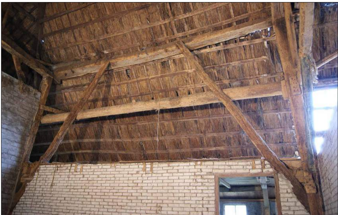
Afb. 80 De bovenbalk aan de noordkant. Op een lager niveau de jaagbalk.
