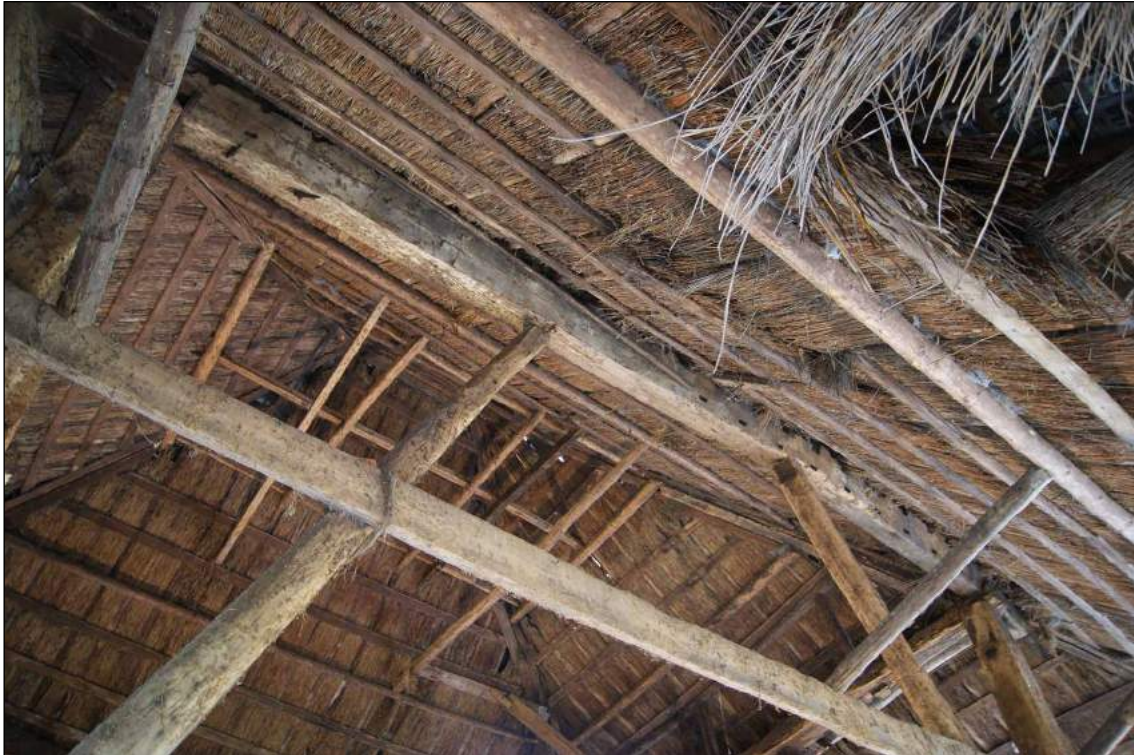
Afb. 103 De hergebruikte molenroede, herkenbaar aan de sleufgaten.
