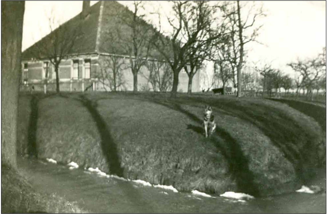
Afb. 55 De stolpboerderij in 1932. Foto: www.geschiedenisschellinkhout.nl
