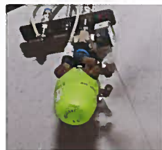
一定の時間になるとミストが天井より噴射される。年間を通して自動制御で湿度の管理を行なっているのだ。
