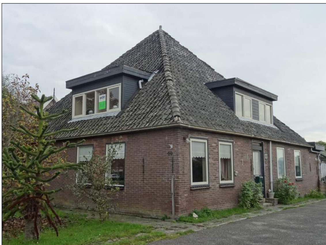
Afb. 11. Stolpboerderij op perceel Bangert 40 voorafgaand aan de sloop.
