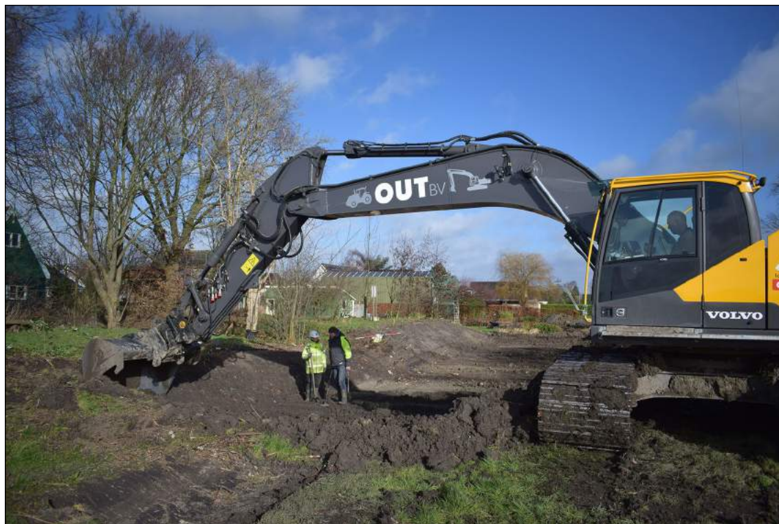
Afb. 17. Het graven van de sloot achter perceel Bangert 36 is in 2019 archeologisch begeleid.
