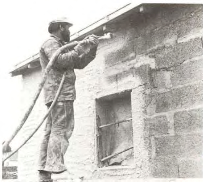
⑫ Projection à la lance par sillons horizontaux juxtaposés
