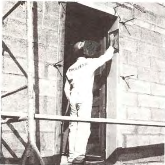
⑩ bis Finition des tableaux à la taloche
