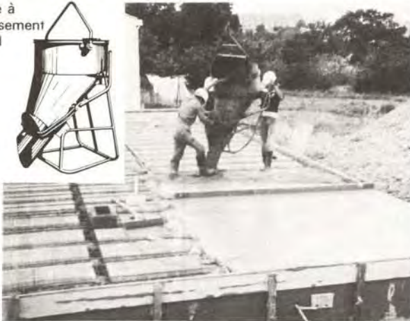
③⑧ Utilisation de la benne à béton
