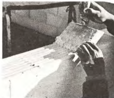
③ Pose au mortier colle
