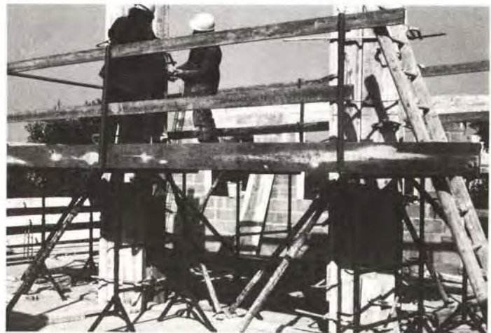
⑭ Échafaudage sur tréteaux avec protection
