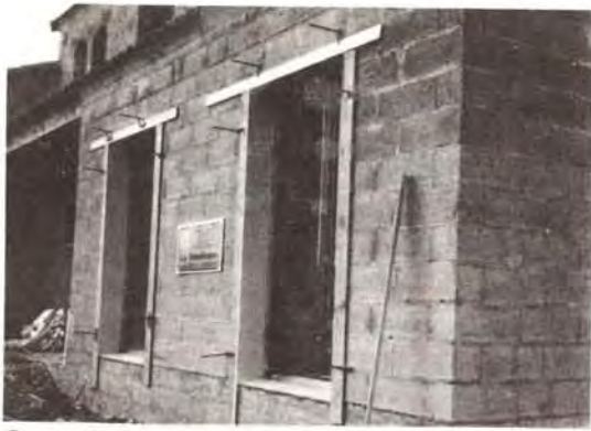
⑩ Coffrage des arêtes de tableaux et sous-linteaux
