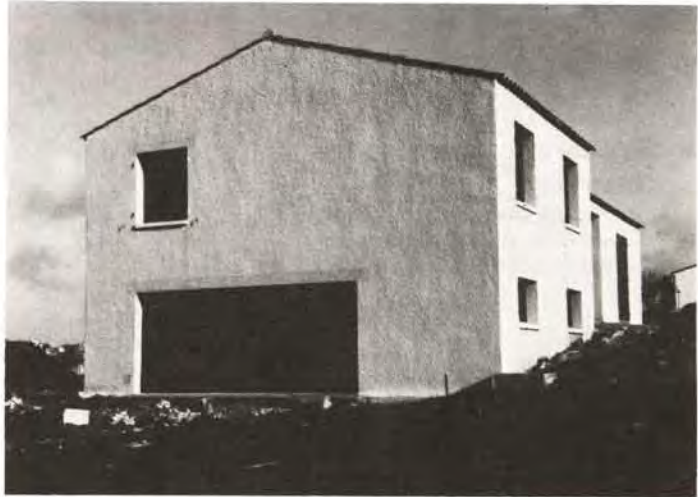
Façades d'un pavillon à étage avec : – baies étroites (fenêtres) – baie large (porte de garage)
