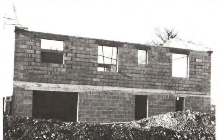
④ Même façade avec linteaux réalisés
