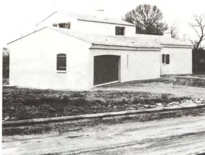
Pavillon avec linteaux nécessitant un fond de moule courbe
