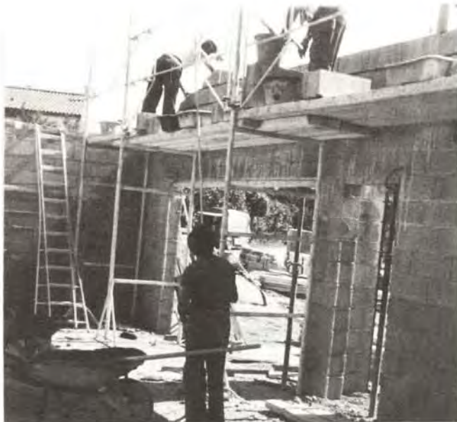
⑫ Montage traditionnel d'un pignon. Échafaudage par tréteaux-échelles
