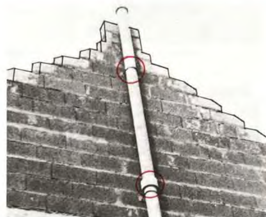
②⑦ Conduit simplement fixé par colliers, du côté intérieur d'un mur pignon
