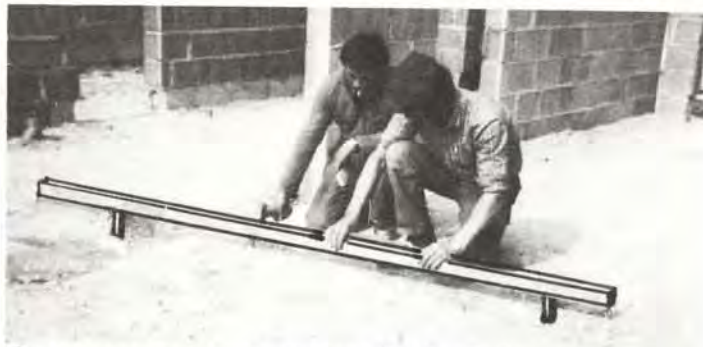
② Réglage de piquets-repères (règle et niveau)
