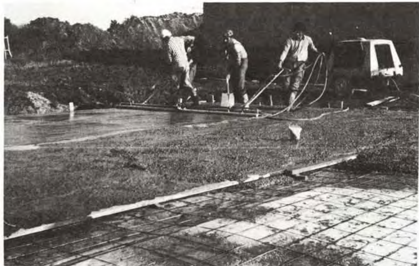
③ Dressement et vibration du béton à la règle vibrante pneumatique
