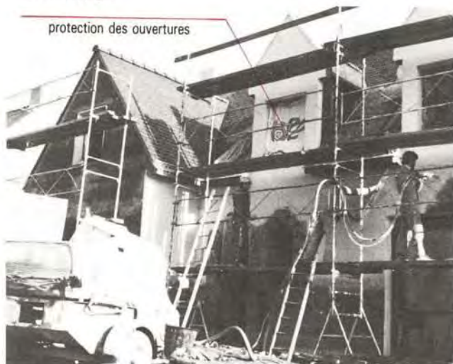
⑪ Enduit monocouche réalisé à l'aide d'un matériel de projection à la lance
