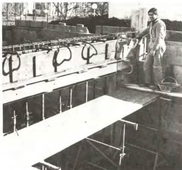
① bis Poutre coffrée d'un refend
