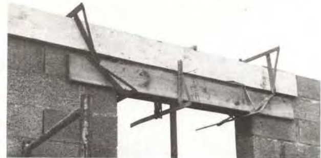
⑥ Linteaux filants coffrés identiquement
