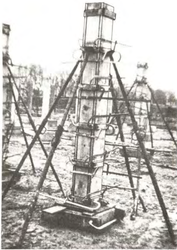
⑩ Coffrage traditionnel
