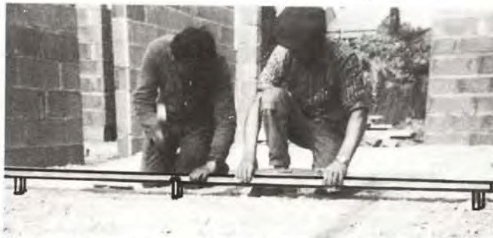
② bis Réglage de piquets-repères intermédiaires
