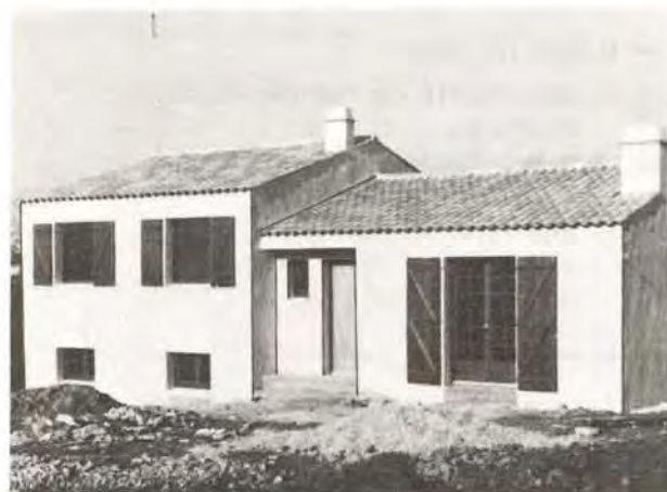
① Murs de façade (enduits terminés)
