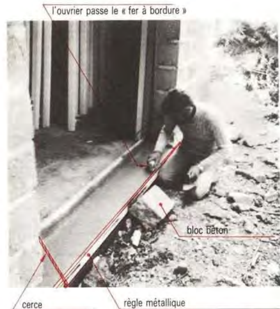
⑪ Réalisation d'un seuil ciment d'une porte-fenêtre
