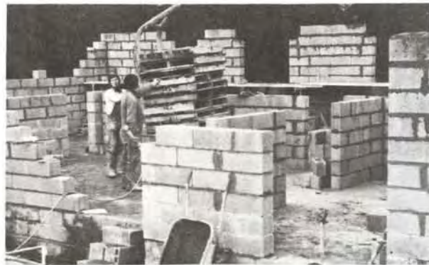
㉕ Maçonnerie effectuée de la façade arrière
