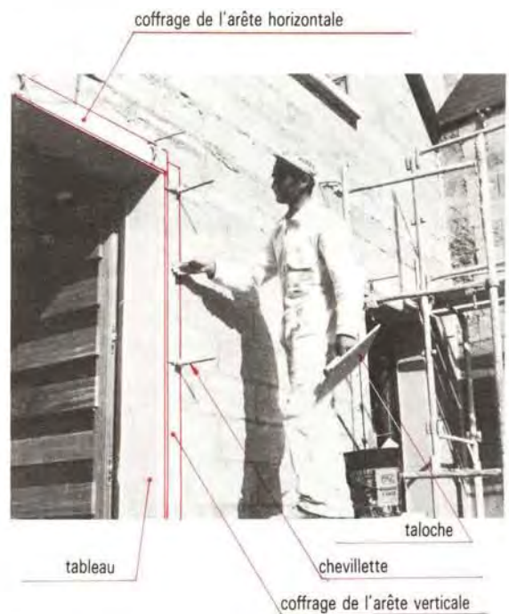
⑮ Enduit des tableaux ( finition talochée)
