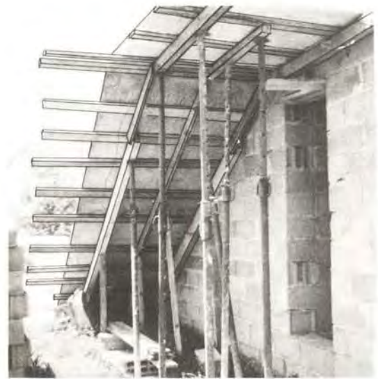
16 Étalement avec raidisseurs longitudinaux et transversaux
