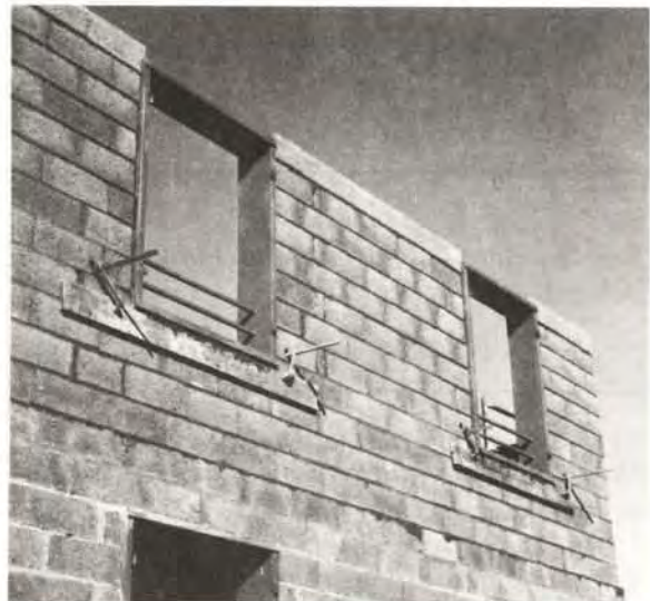
(28) Mise en place de cadres métalliques
