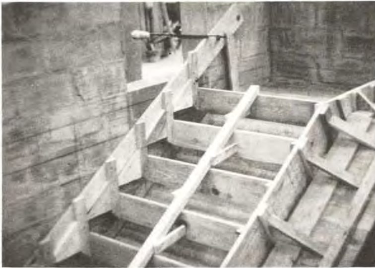
15 Escalier droit coffré
