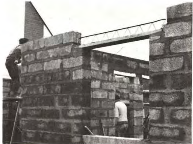
(24) Prélinteau réglé à hauteur et de niveau sur un lit de mortier
