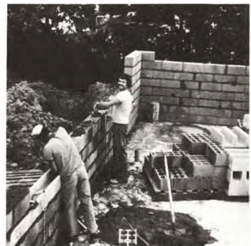
⑫ Façon en série des joints verticaux des blocs
