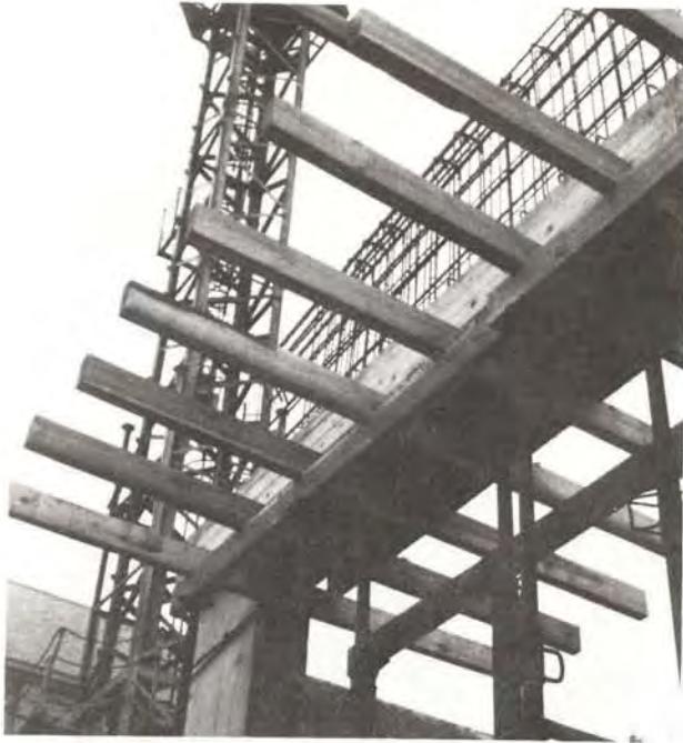
⑧ Étaieement d'une poutre de grande portée
