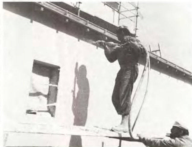
㉓ Deuxième passe : finition « brut de projection »
