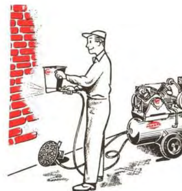
compresseur + projecteur d'enduit
