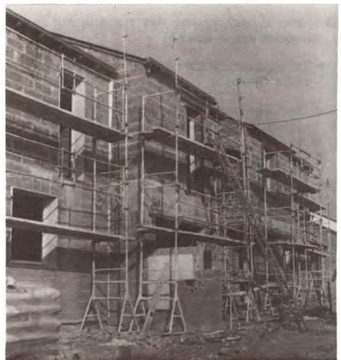
⑦ Échafaudage en cours de montage
