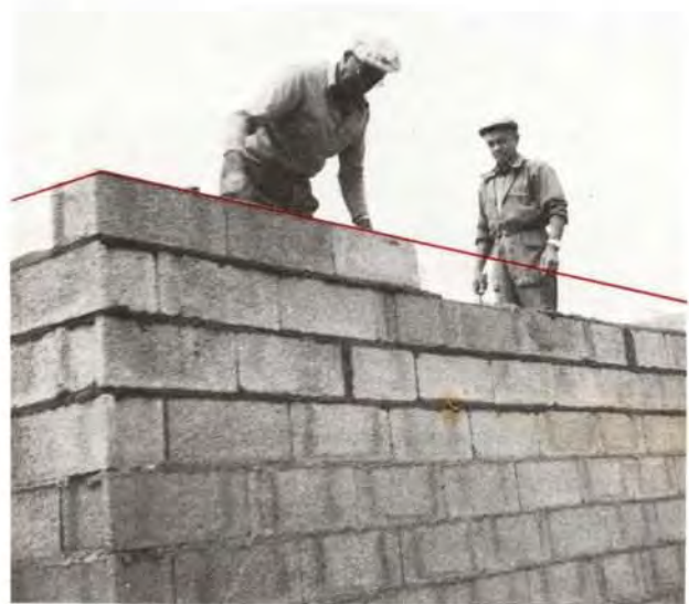
㉑ Pose des blocs en ligne
