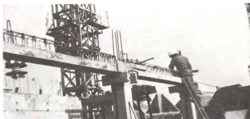
②③ Mêmes poutres mises en place pour recevoir le plancher
