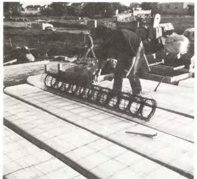
②⑨ Mise en place du treillis soudé
