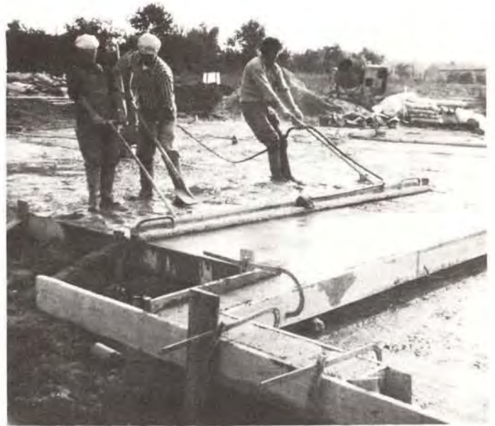
④③ Utilisation de la règle vibrante
