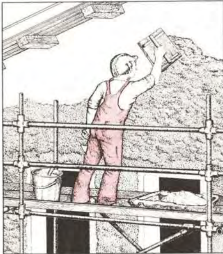
⑯ Couche de finition talochée au fur et à mesure de l'application du mortier
