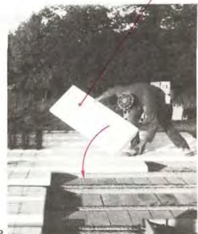
㉖ Montage composite : entrevous béton et entrevous polystyrène
