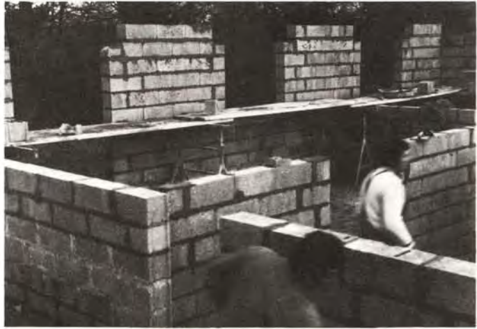
④ La maçonnerie de blocs de la façade arrière est terminée.
