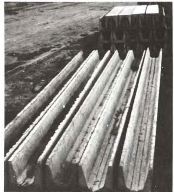
②9 Bloc en U en béton moulé pour linteaux
