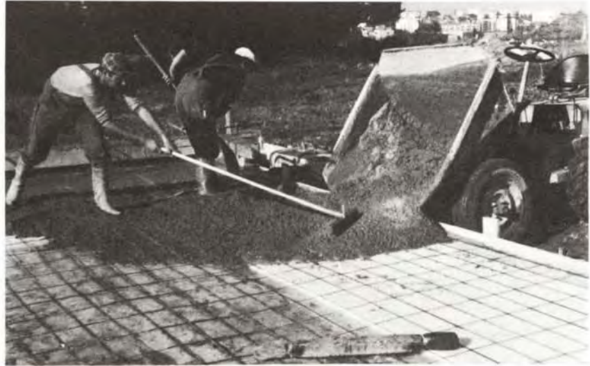
① Transport du béton avec le dumper suivi de l'épandage
