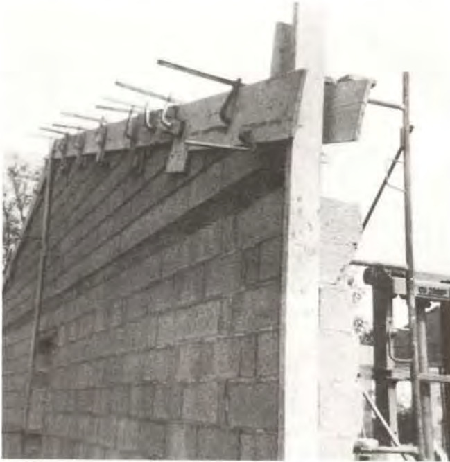
⑮ Coffrage sommaire d'un rampant
