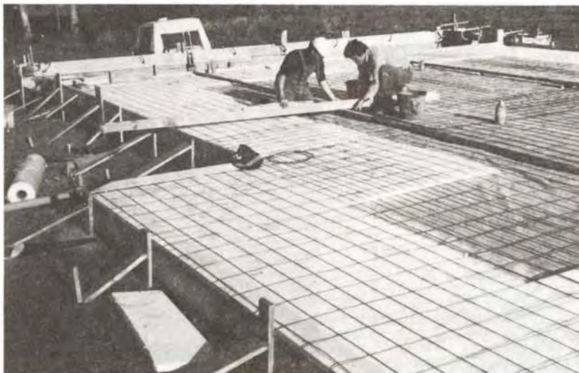
②⁹ Pose de l'isolant, du film étanche et du treillis soudé
