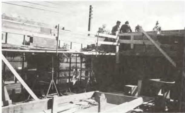
⑳ Échafaudage par tréteaux avec protection
