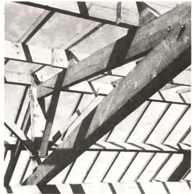
⑫ Charpente traditionnelle : ferme, pannes, chevrons
