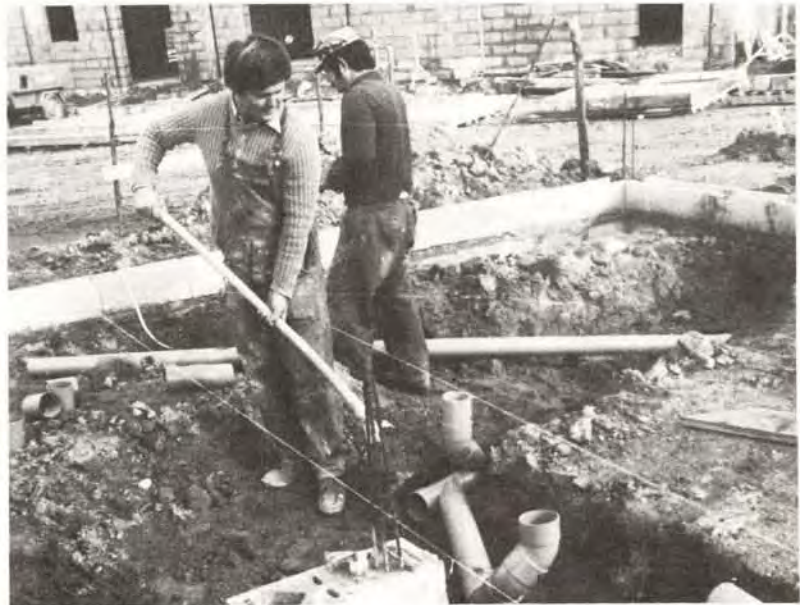
18 Fouille en rigole effectuée manuellement
