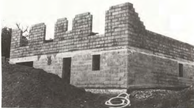
㉒ Murs de façade en construction
