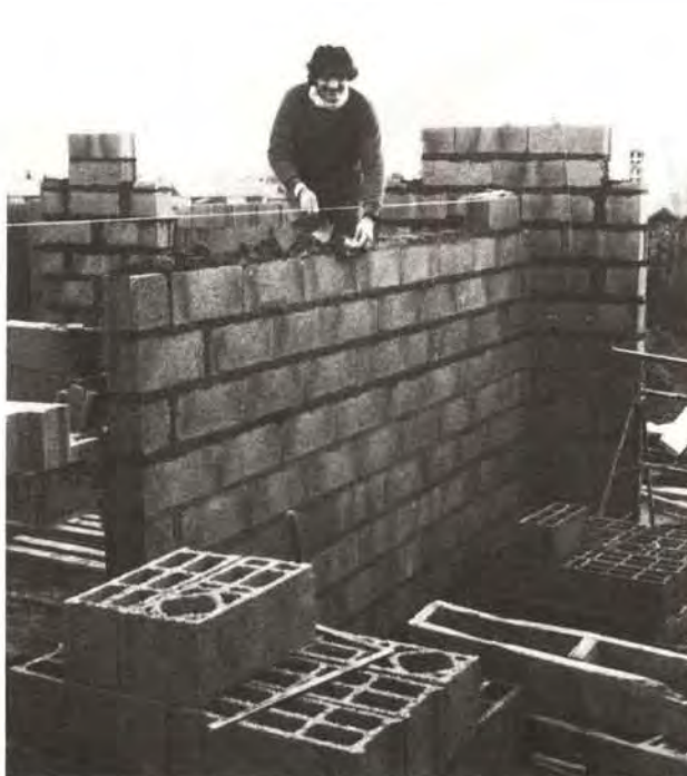
③ bis Mise en œuvre des blocs
