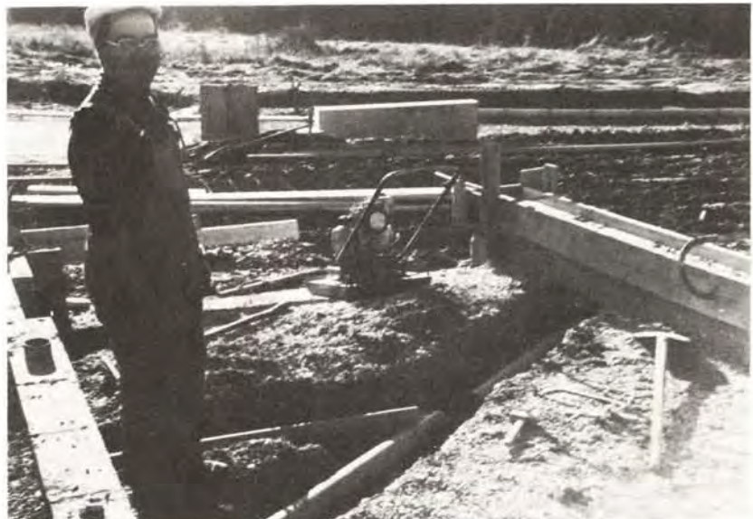
21 Mise en place des canalisations en P.V.C.
