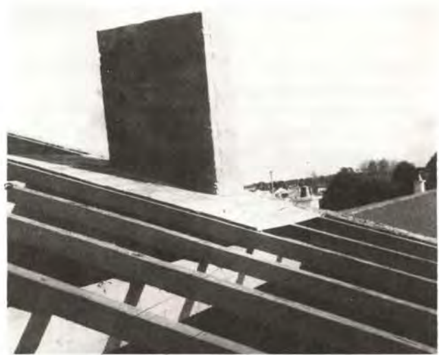
⑪ Charpente très élémentaire : pannes, chevrons Souche de cheminée
