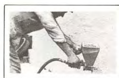
Application d'enduit (plaque n° 1, 3 trous de 14).
