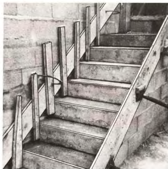
⑲ Volée d'escalier après bétonnage
