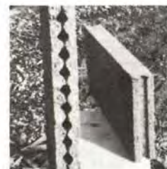
⑮ Linteau de garage avec planelles pour obtenir un support homogène
