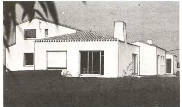
① Travaux courants d'enduits sur murs de façade
