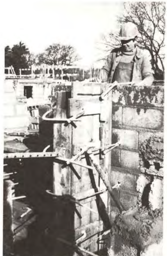
Coffrage d'un poteau adossé dans un ensemble pavillonnaire
