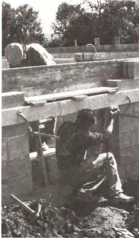
⑤ Coffrage en cours d'exécution
