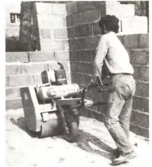
⑬ Compactage d'un remblai pour confection d'un dallage
