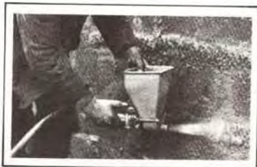
Projection à l'aide d'un pot type « Sablon »
