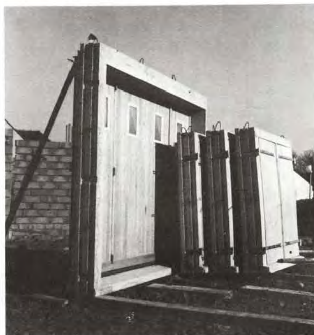
㉖ bis Stockage de blocs-baies (cadres en béton)
