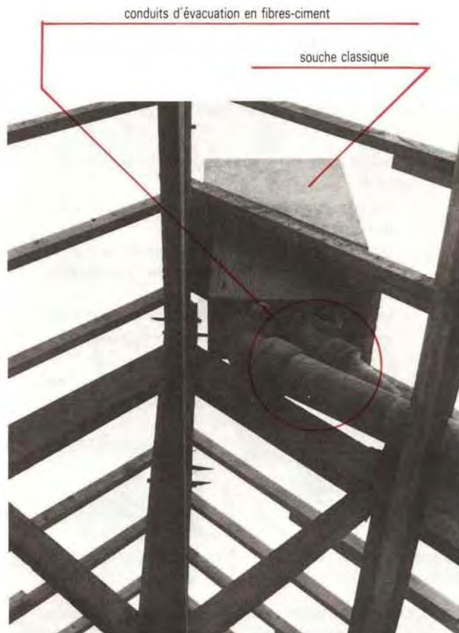
③④ Traversée de charpente traditionnelle
