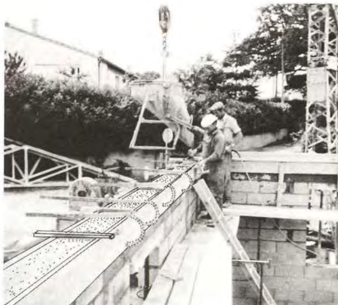
③⑪ Coulage du béton du chaînage et vibration
