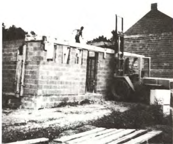
③⑩ Chariot élévateur avec caisse à béton placée sur la fourche
