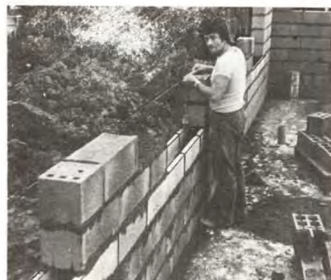
(28) Blocs béton en U pour chaînage B.A.
