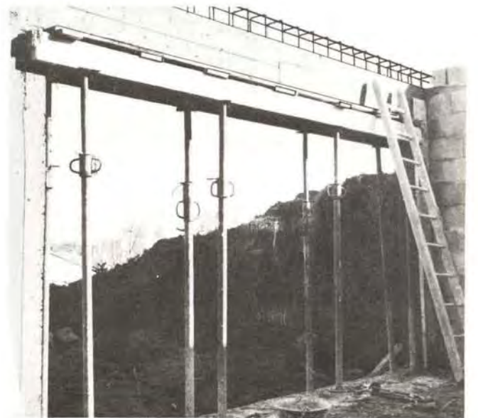
⑯ Étaie par double file d'étais. Linteau-poutre de garage
