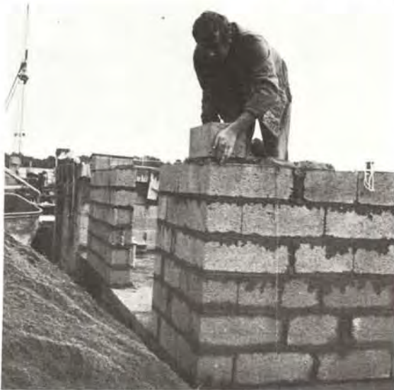
㉐ Pose d'un bloc d'angle au fil à plomb
