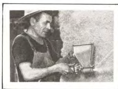
Crépissage : application à environ 0,50 m du mur.
