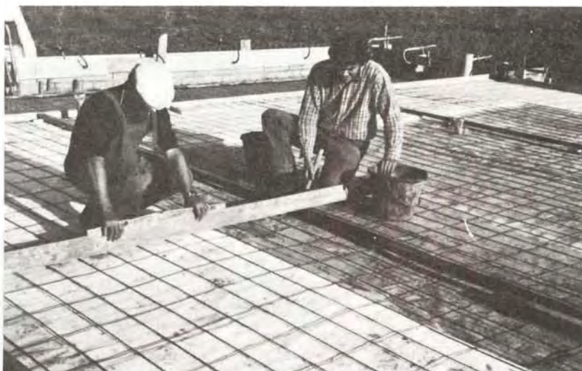
③⁰ Réglage des guides à hauteur à l'aide du niveau a) Sens transversal
