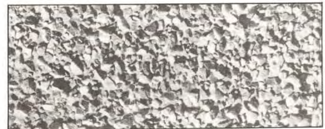
②⑦ Finition avec granulats projetés
