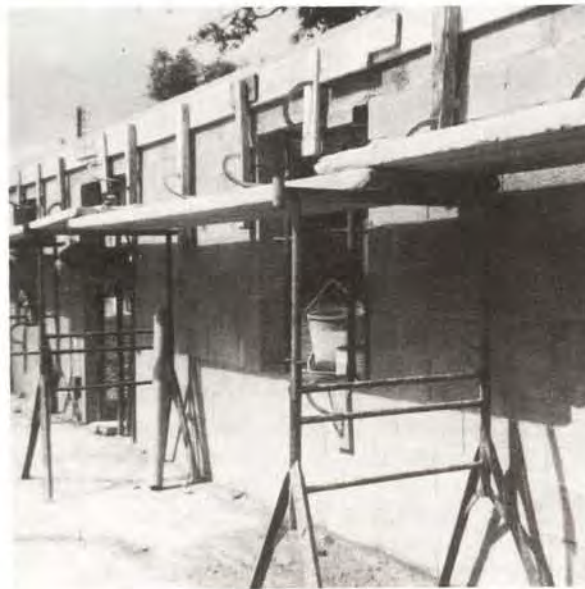
⑨ Coffrage de linteaux-chaînages : • Vue d'ensemble côté intérieur. Les garde-corps font défaut (sécurité ?)
