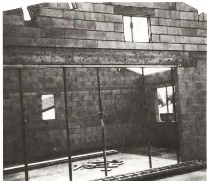
⑦ Poutre intérieure de grande portée
