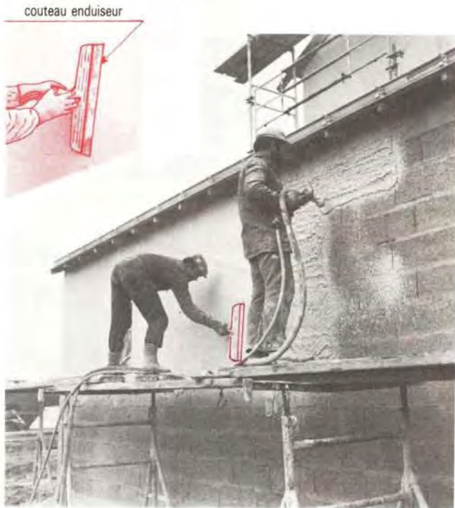
⑳ Serrage de l'enduit au couteau d'enduseur Projection continue du mortier
