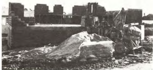
㉓ Même chantier côté ouest : stockage granulats, liant sous bâche, bétonnière, chariot élévateur avec palette de blocs
