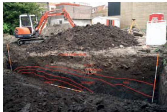
De bodemopbouw op de locatie Vogelpoel. Aan de rechterkant bevindt zich de rooijlijn van de Westerdijk. De oudste fase van de dijk bestaat uit compact veen. Daaroverheen zijn diverse ophogingslagen van veenplaggen en klei opgeworpen
