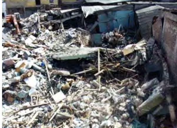
Yenikapı'da Zemin Kaymasına Bağlı Olarak Meydana Gelen Bina Çökmesi
