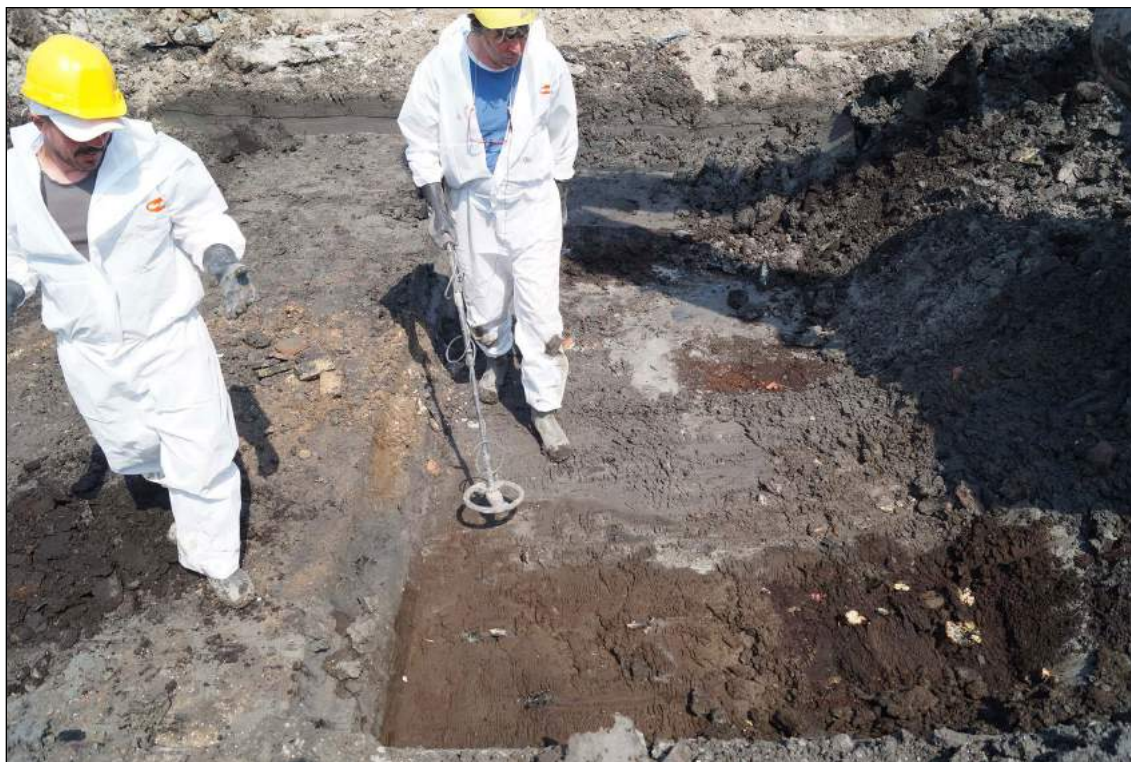
Afb. 3.4. De vlakken en de stort werden met de metaaldetector afgezocht door een specialist op dit gebied.
