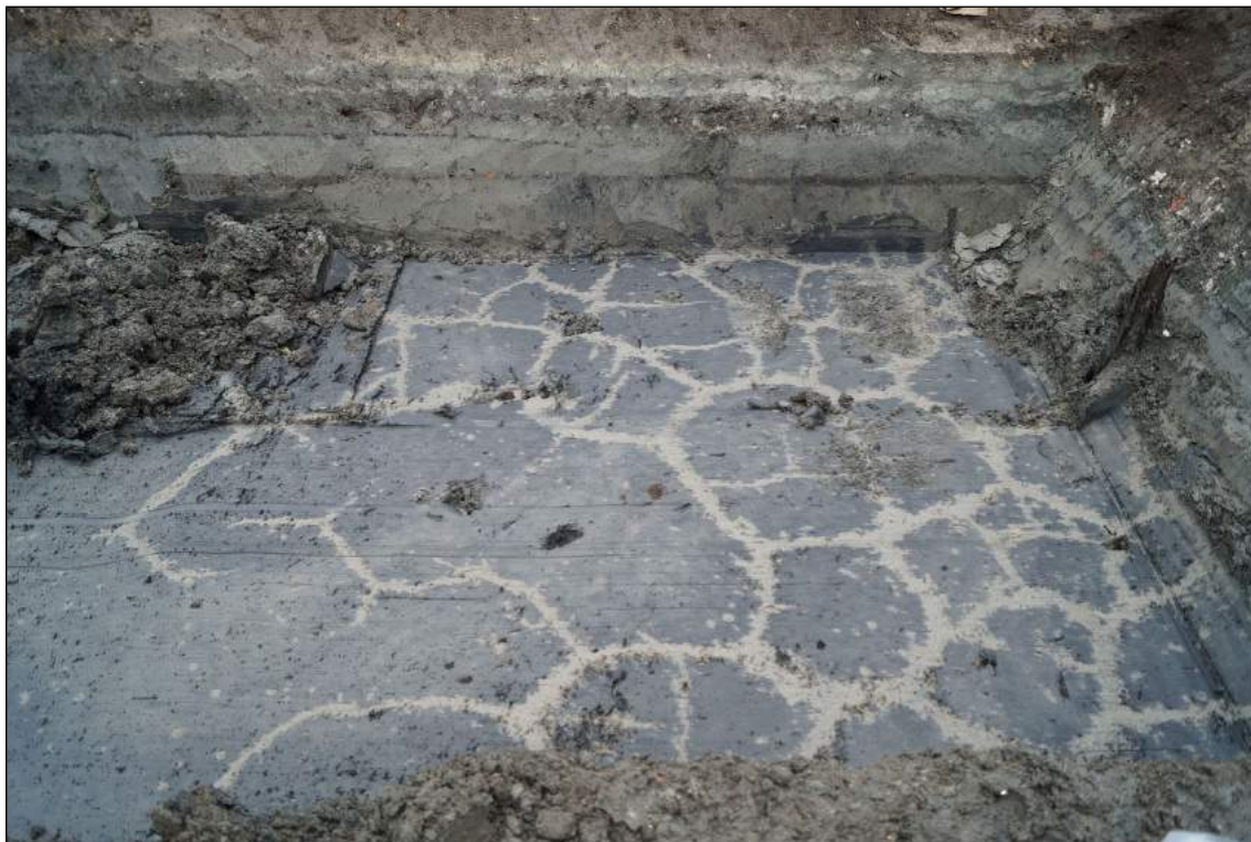
Afb. 5.2.5. Bij de aanleg van het vlak waren de krimpscheuren in de grijze klei goed zichtbaar.
