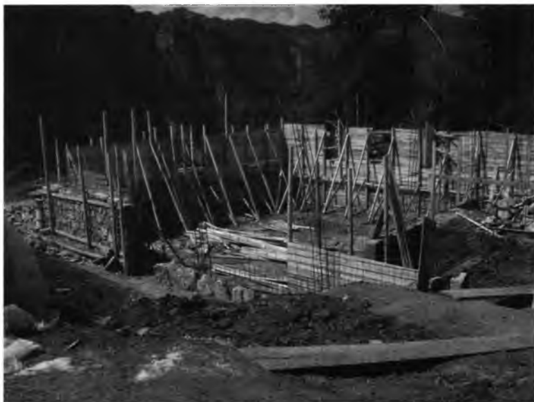
Сл. 4 Манастир Довоља, реконструкција приземља манастирског конака
