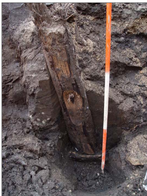
Afb. 15 (links) Stijl van de zuidoosthoek van het huis, gefundeerd op een liggend plankje. De paal is dendrochronologisch gedateerd op najaar/winter 1310/1311.
