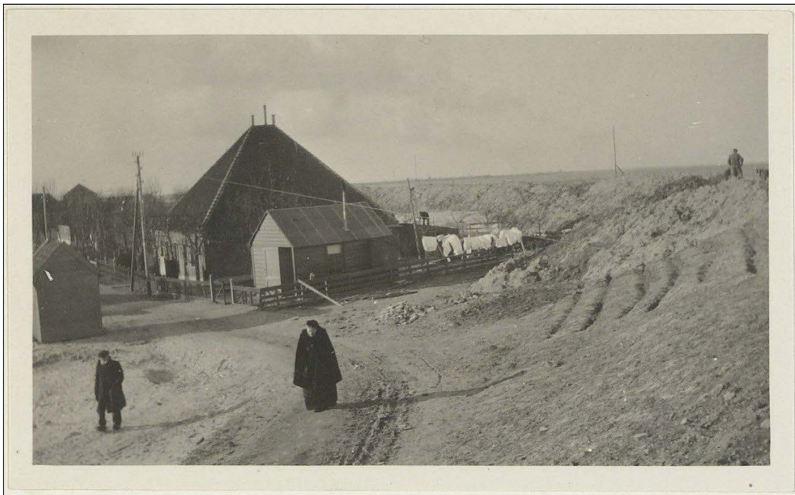
In september 2022 werd een oude foto overhandigd aan de huidige bewoners van de stolp aan Warde 189, waar de Dorpsstraat tegen de huidige Markermeerdijk aan loopt. Dit was beloofd tijdens de opgraving die daar plaatsvond in het kader van de dijkversterking door de Alliantie Markermeerdijken in de zomer van 2022.
