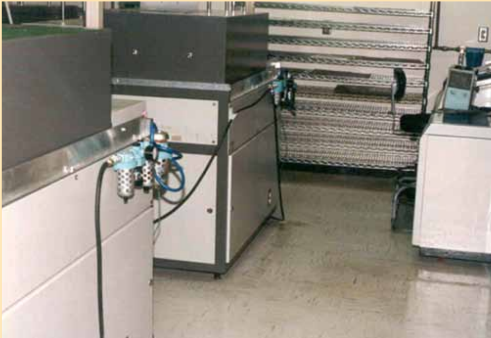
Şekil 5.3. Test makinesi basınçlı hava kullanım noktası bağlantısı
