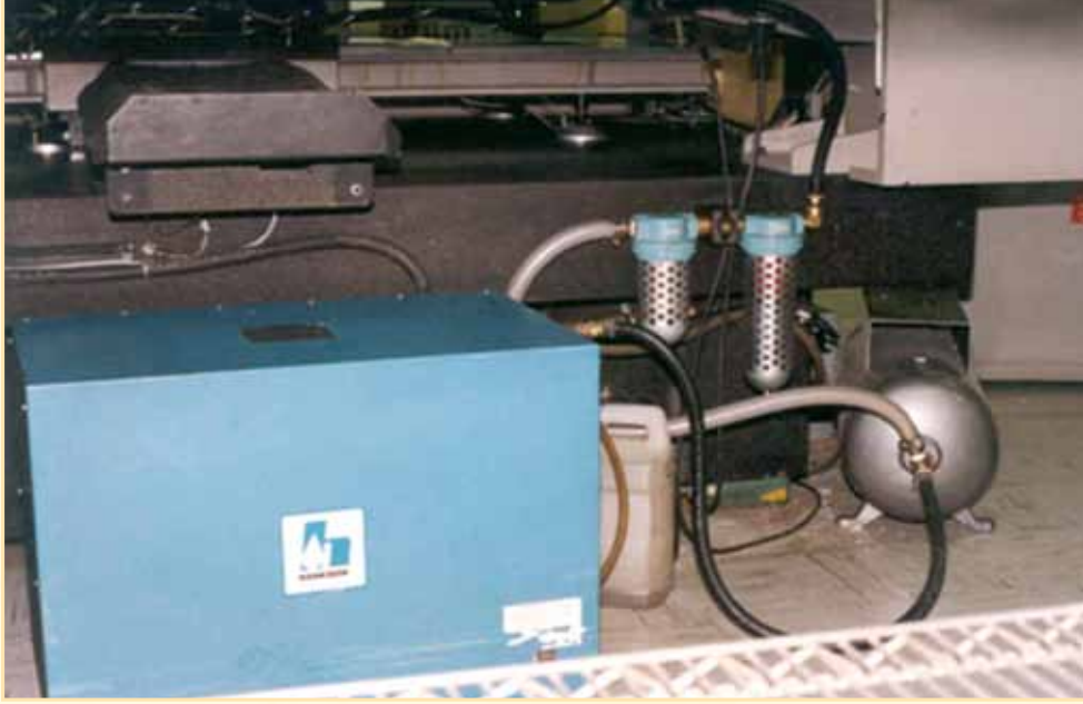
Şekil 5.5. Kullanım noktası boru düzeni örnekleri
