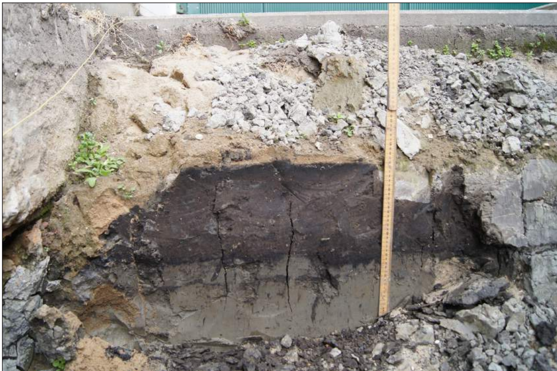
Afbeelding 11. Het kleine profiel dat kon worden afgestoken direct achter het bedrijfsgebouw. Duidelijk zichtbaar is de vlekkerige menglaag (donkerbruingrijs) met daaronder de matig slappe klei (lichtgrijs).
