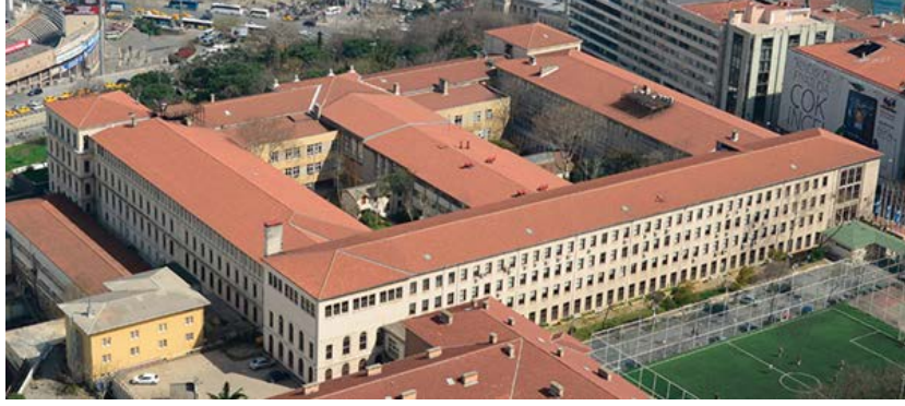
Şekil 1. İTÜ Makina Fakültesi Binası [2].
