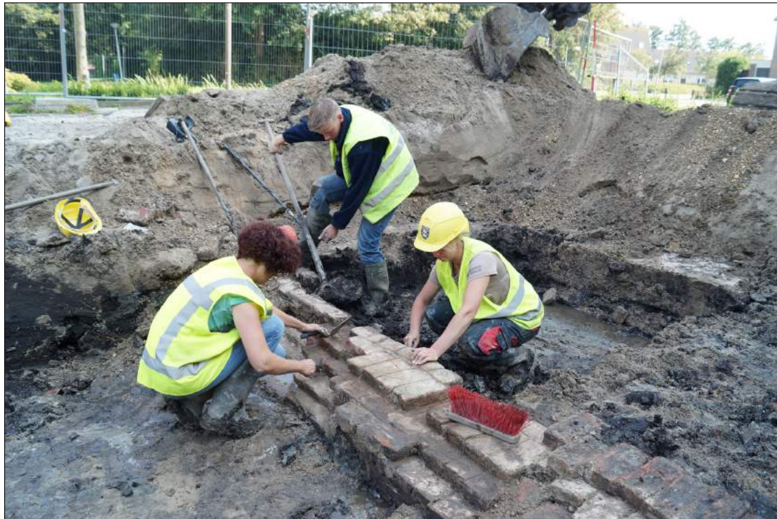
Afbeelding 19. Het schoonmaken van de bakstenen funderingen van het 17 de - of 18 de -eeuwse langhuis (zuidzijde werkput 3).
