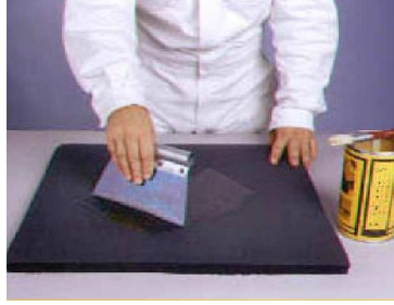
Resim1.21: Elastomerik kauçuk köpüğün kanala uygulanması
