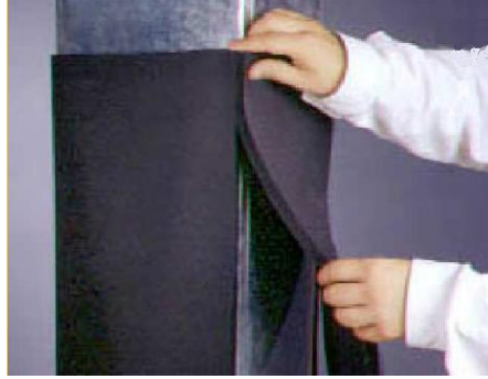
Resim1.20: Elastomerik kauçuk köpüğü yapıştırıcısının sürülmesi
