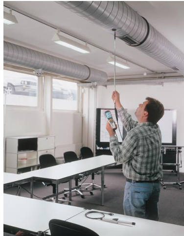
Resim 3.2: Havalandırma kanallarında gürültü ölçümü
