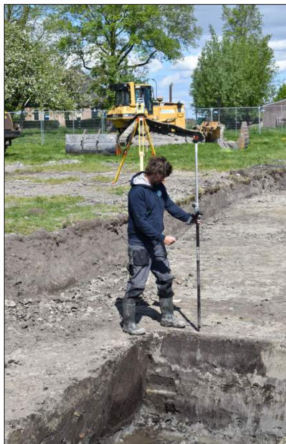
Afbeelding 5. Een verdiept vlak wordt met GPS ingemeten.
