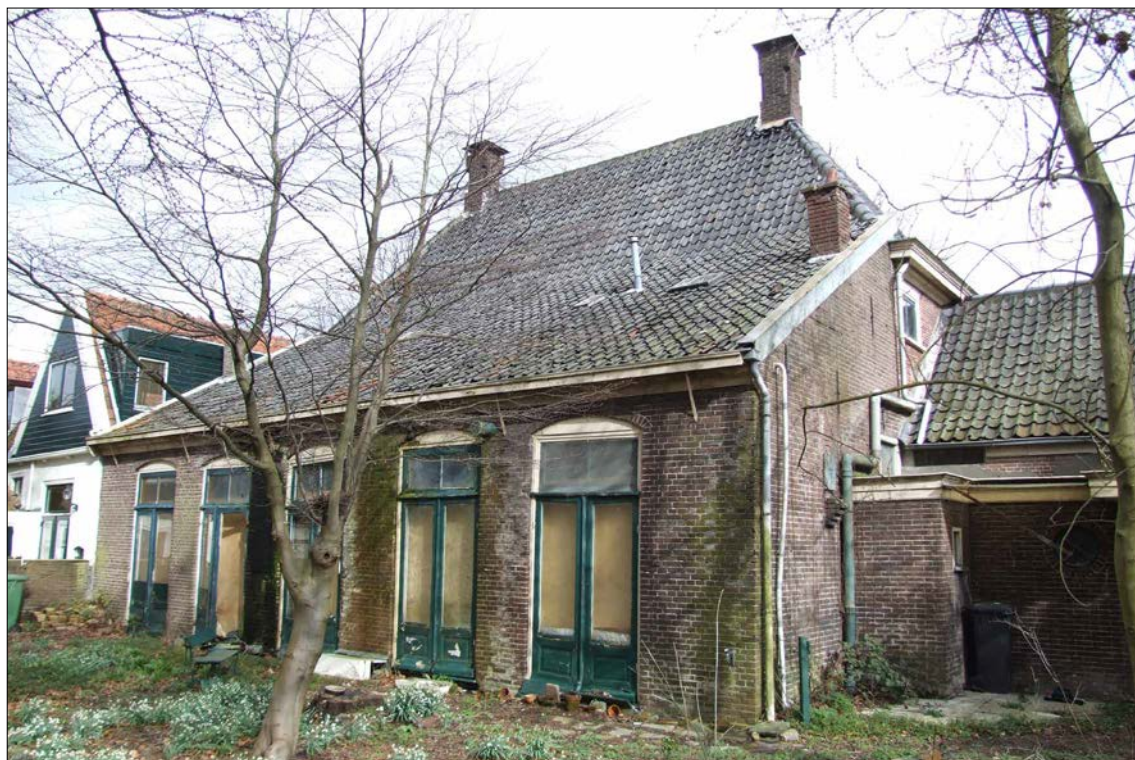
Afb.18 De achterzijde van het pand Koepoortsweg 73 voorafgaand aan de restauratie en verbouw. De aanbouw is in 1876 toegevoegd door de toenmalige eigenaar Dirk Tool.
