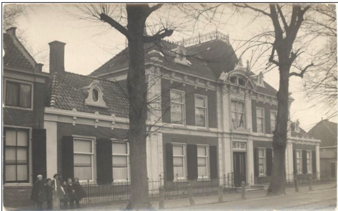
Afb.43 Koepoortsweg 35 voor de sloop in 1931. Het complex is vergelijkbaar met Koepoortsweg 73: een hoofdgebouw met aan weerszijden kleine bijgebouwen.
