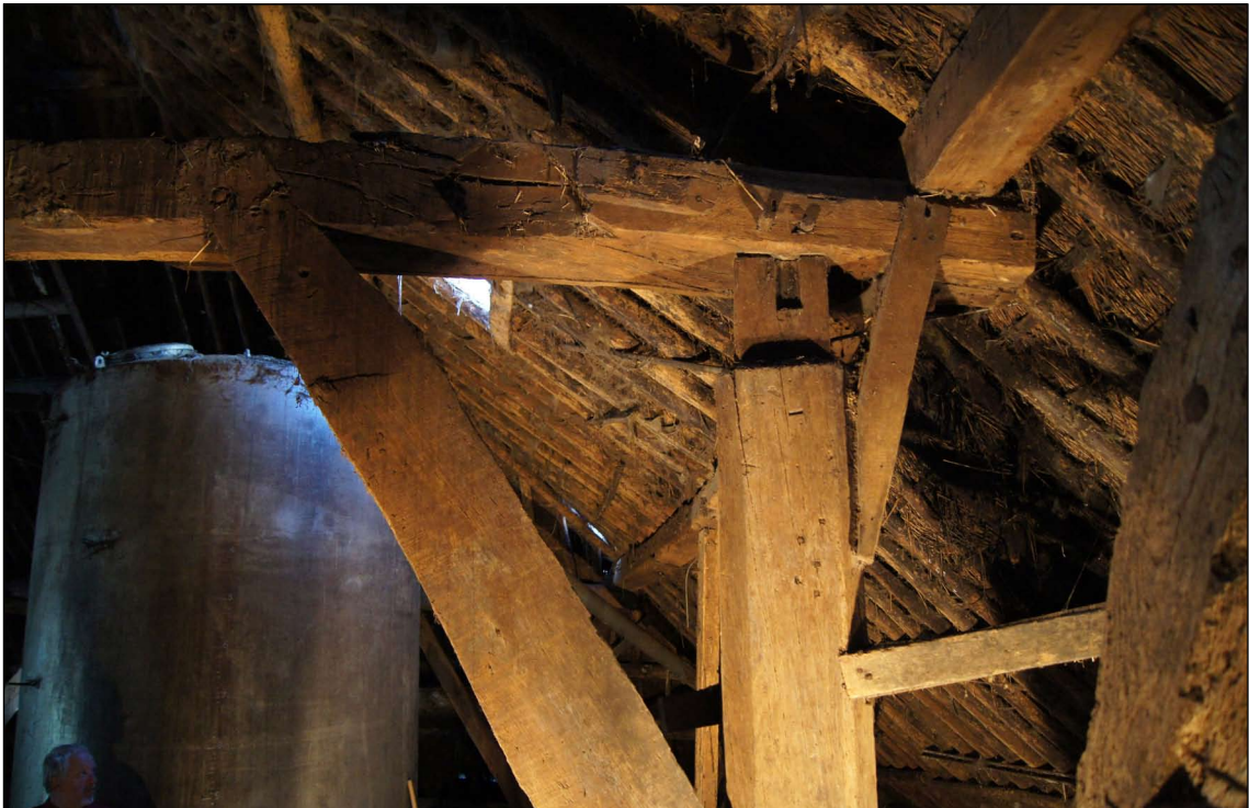
Afb. 47 Een deel van het eikenhouten vierkant van stolpboerderij Koningspade 13 in Hoogwoud. Voor de bouw van het eiken vierkant is vermoedelijk gebruik gemaakt van oude onderdelen van een molen.
