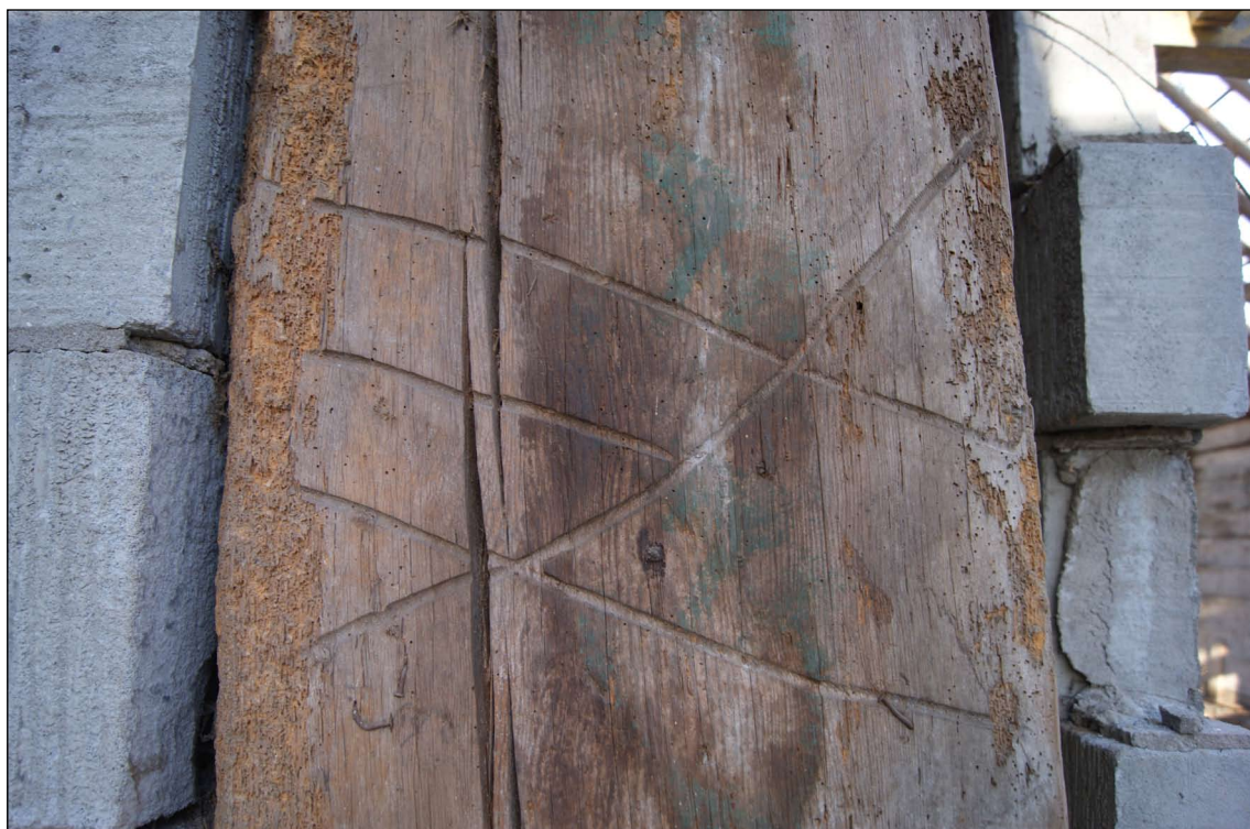
Afb. 35 Een groot ingegutst merk op een vierkantpaal in stolpboerderij Kerkebuurt 196 in Berkhout. De boerderij is eind 2012 gesloopt.
