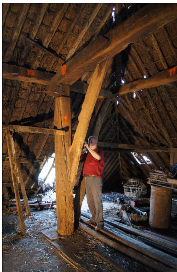
Afb. 27 Het nummeren van de elementen van het vierkant van boerderij Koningspade 13 in Hoogwoud. Uit de genummerde balken zijn na de sloop houtmonsters gezaagd voor dendrochronologisch onderzoek. Augustus 2012.
