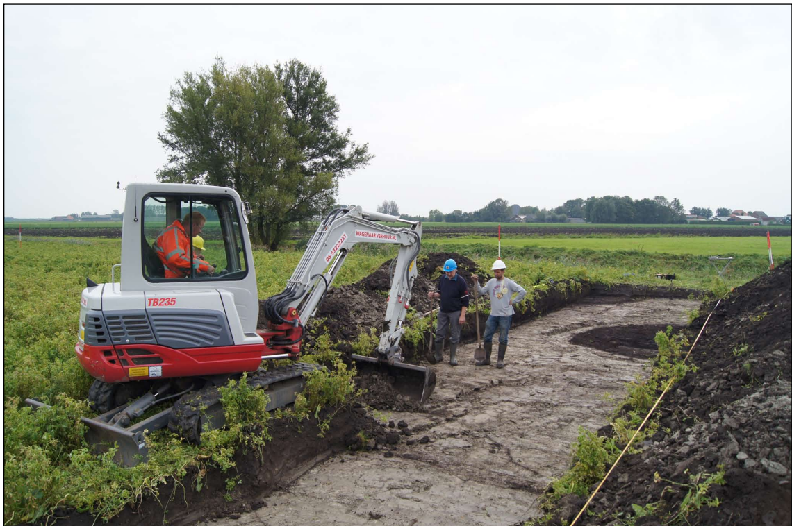
Afb. 4 Aanleg van een proefsleuf. Opgraving De Tuinen, Ursem. September 2012.
