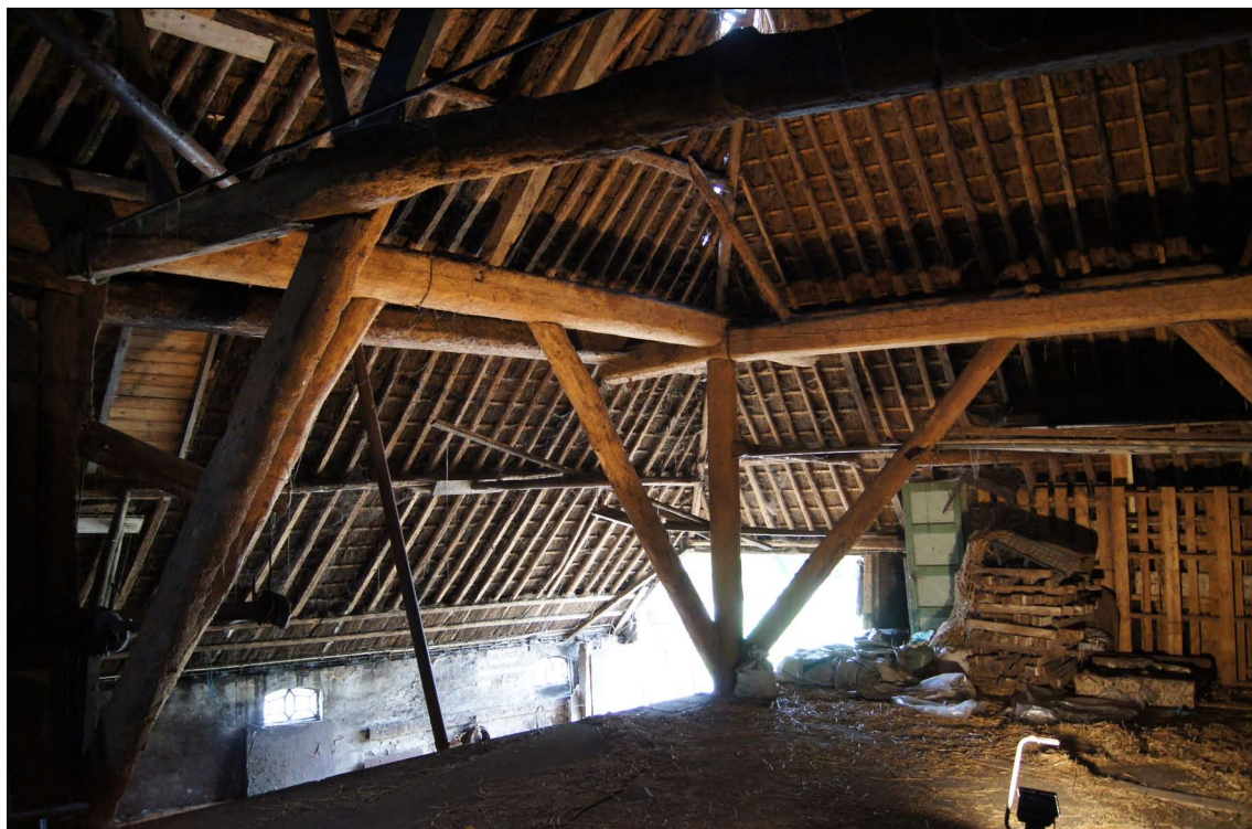
Afb. 16 Het grenenhouten vierkant van boerderij Koningspade 13 in Hoogwoud tijdens de bouwhistorische opname. De boerderij is in september 2012 gesloopt.
