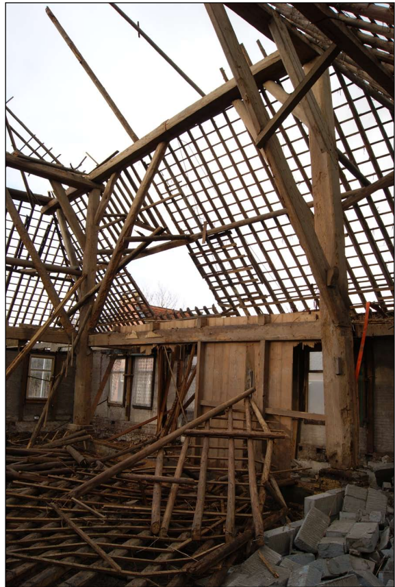
Afb. 65 Een deel van het vierkant van stolpboerderij Kerkebuurt 196 in Berkhout tijdens de sloop, november 2012.
