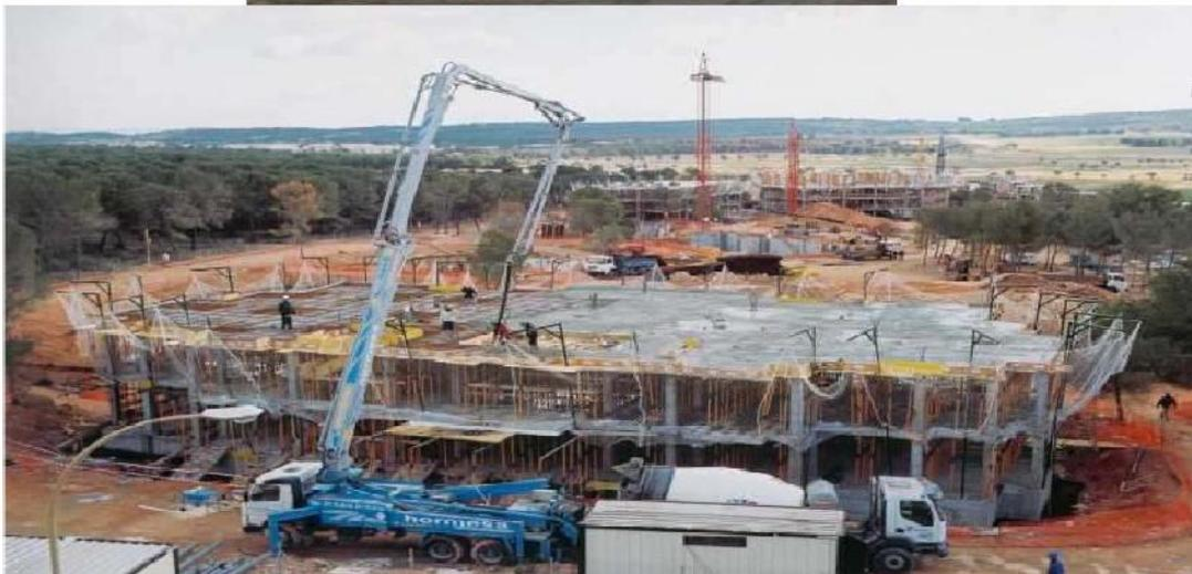
*Bomba de hormigonado (F. Superior) ; Puesta en obra de hormigón con bomba (F.Inferior).*
