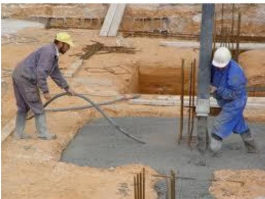
*Consolidación con vibrador interno*
