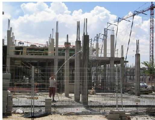
*Riego con agua, en el curado de pilares.*
