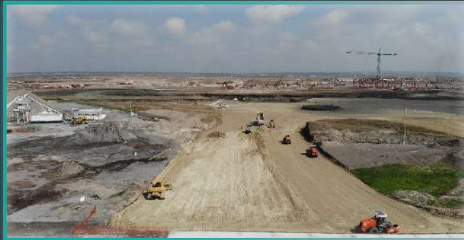
Compactación y nivelación de suelo en Calles de Rodaje
