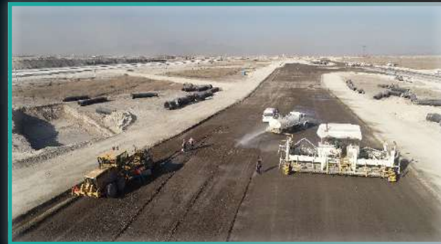
Colocación de base hidráulica sobre Calles de Rodaje
