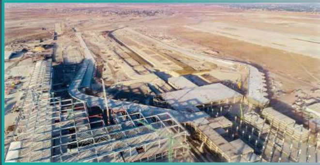
Construcción del Eje Troncal de Circulación
