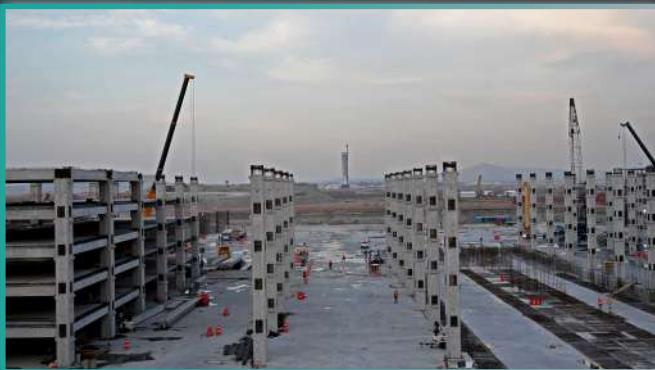
Construcción del Estacionamiento del AIFA
