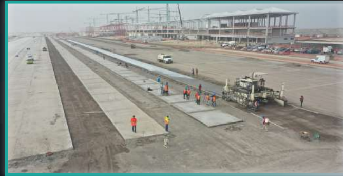
Colocación de concreto hidráulico
