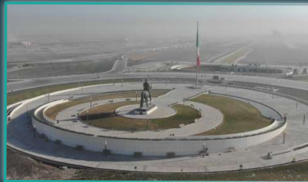
Superficie de construcción de vialidades: 6.2 millones de m 2
