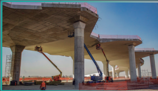
AIFA: 2,8 millones de m 3 de concreto
