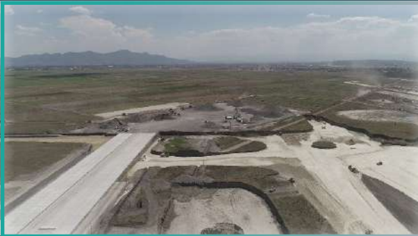
Excavación en Calles de Rodaje
