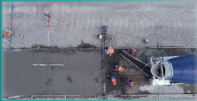
Colado de concreto magro sobre Calles de Rodaje
