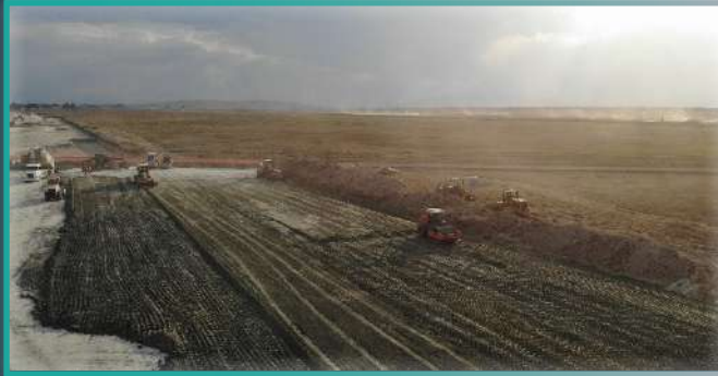
• Compactación de terraplén en Pistas
