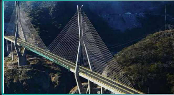
Puente Bahuarte: 90,000 m 3 de concreto
