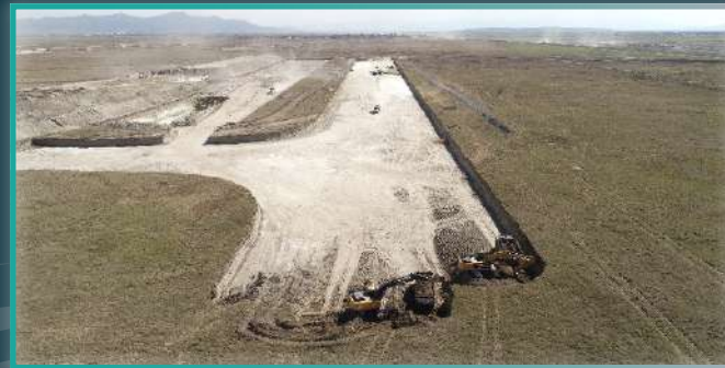
Excavación en Pista Norte
