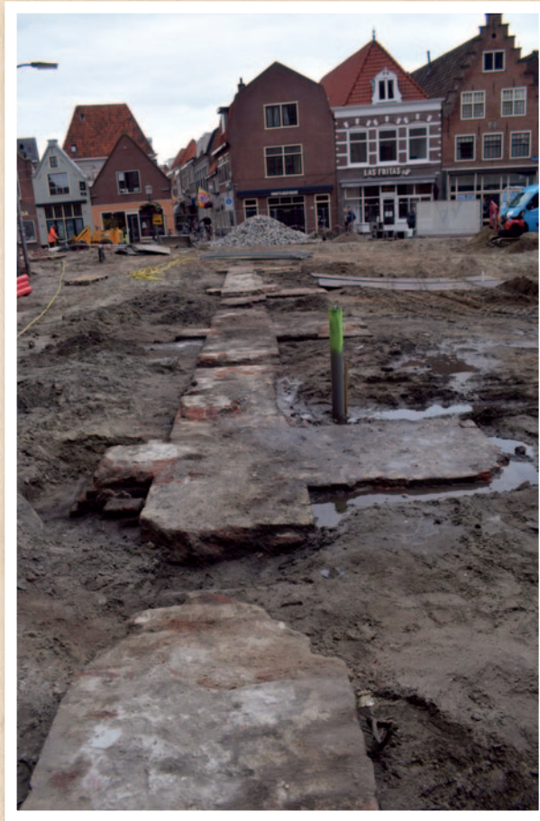
Een deel van de opgegraven noordelijke zijgevel van de middeleeuwse kerk.
