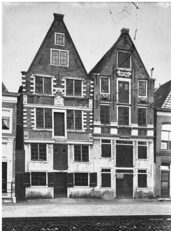
Afb 1 De Zeevaart uit 1610 (links, nr 20) en De Dolphijn uit 1660 (rechts, nr 19) vlak voor de sloop in 1942 (foto RCE)
