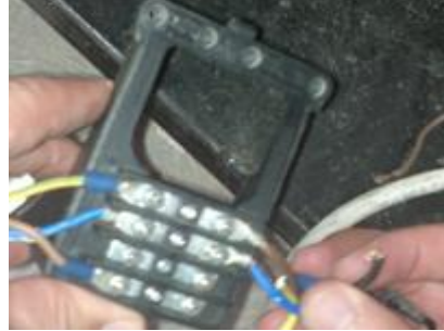
Resim 6.3:Termostatın bağlantıları
