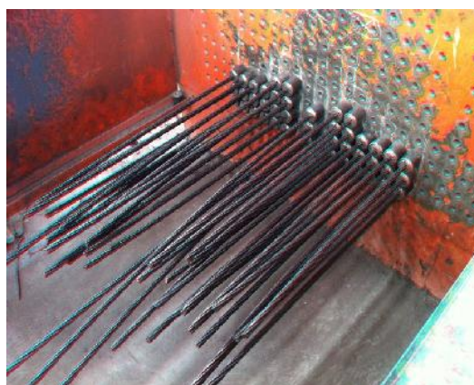
Cordones de pretensado en el molde de vigas
