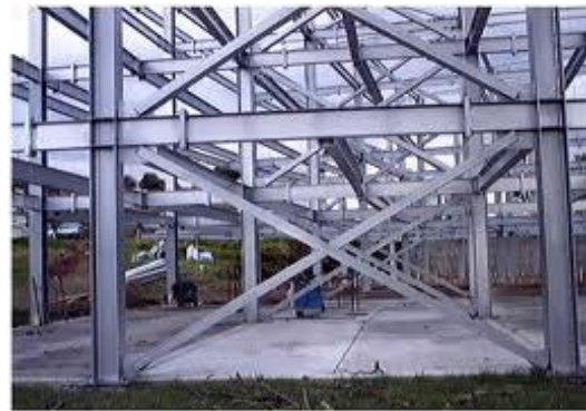
Estructura metálica con perfiles normalizados.
