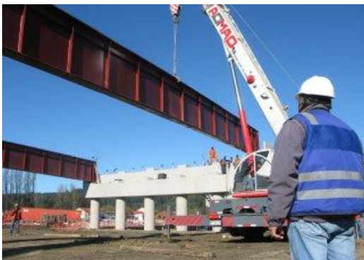
Montaje de vigas de 50 m. en un puente.
