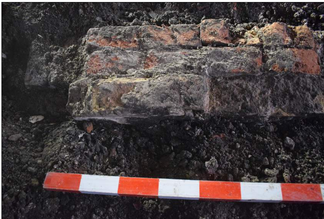
Afb. 17. Aan de binnenzijde van de kelder werd een nieuwe muur geplaatst, waarschijnlijk vanwege vochtdoorslag.
