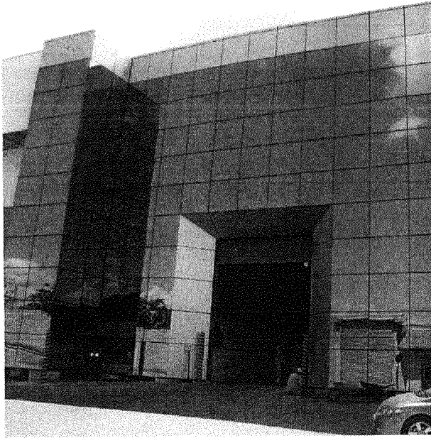
Entrada principal - Galpão Principal
