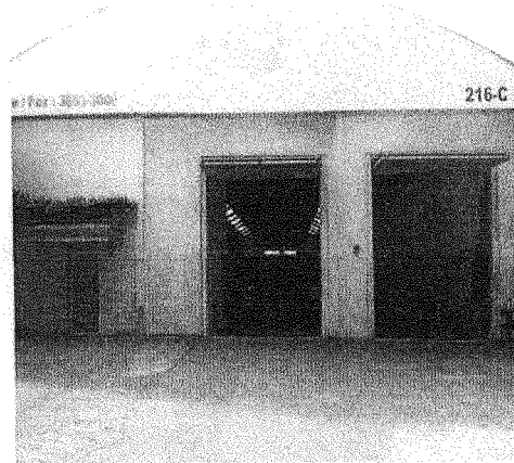
Entrada para carga e descarga
