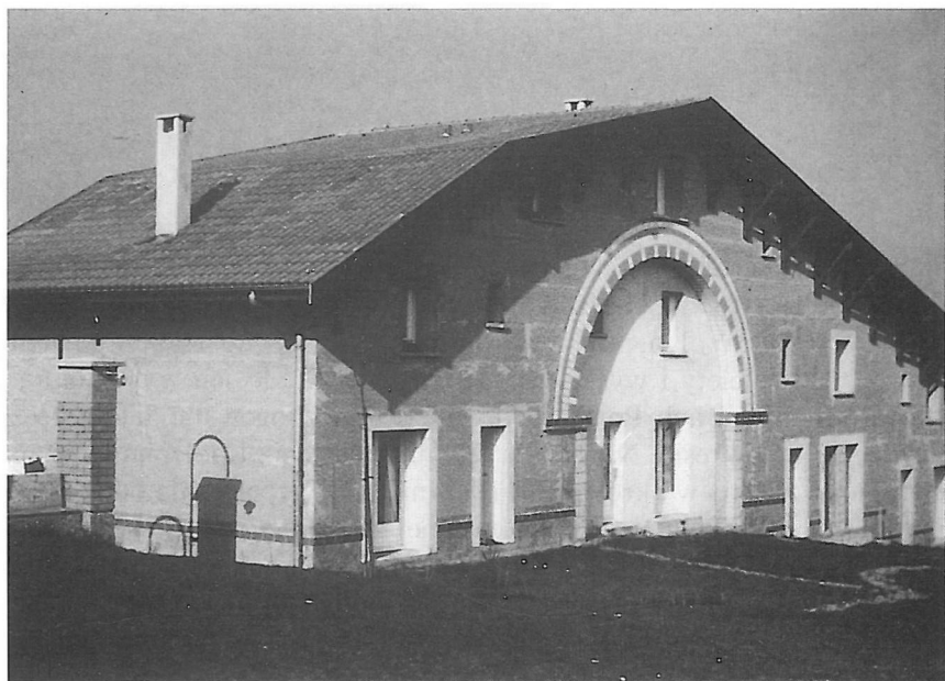
Współczesny budynek mieszkalny z gliny w osiedlu Domaine de la Terre w L'Isle d'Abeau/Isère — Francja, fot. Ecomusée Nord Dauphine.
