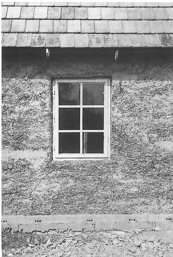
Wypełnienie szkieletu lekką gliną w szalunku przestawnym, fot. M. Hyla.
