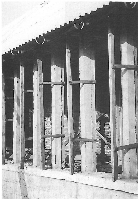
Szkielet żelbetowo-drewniany budynku w Sierczy, proj. arch.arch. Danuta i Maciej Hyłowie, fot. M. Hyła.
