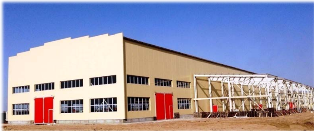
Монтаж стеновых панелей
