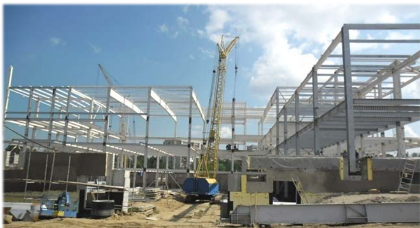
Монтаж конструкций каркаса
