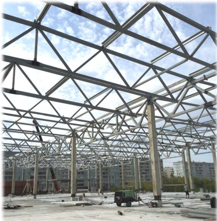
Монтаж каркаса здания
