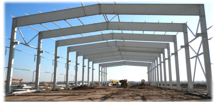
Монтаж каркаса производственного блока
