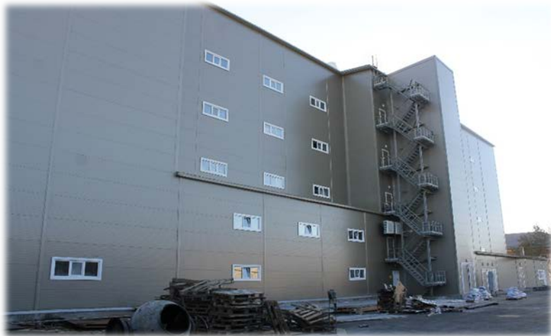
Общий вид здания мельницы
