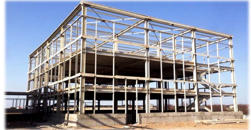
Монтаж каркаса офисного здания
