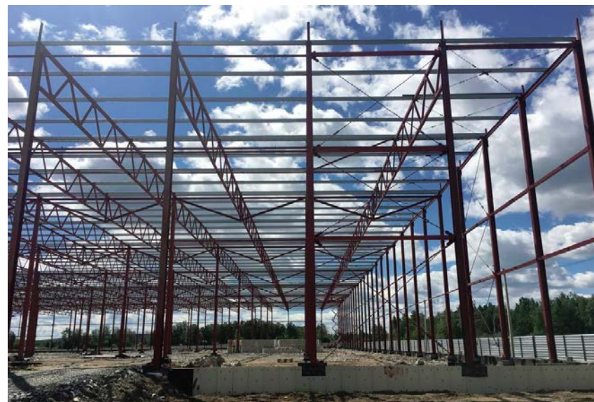
Монтаж каркаса здания
