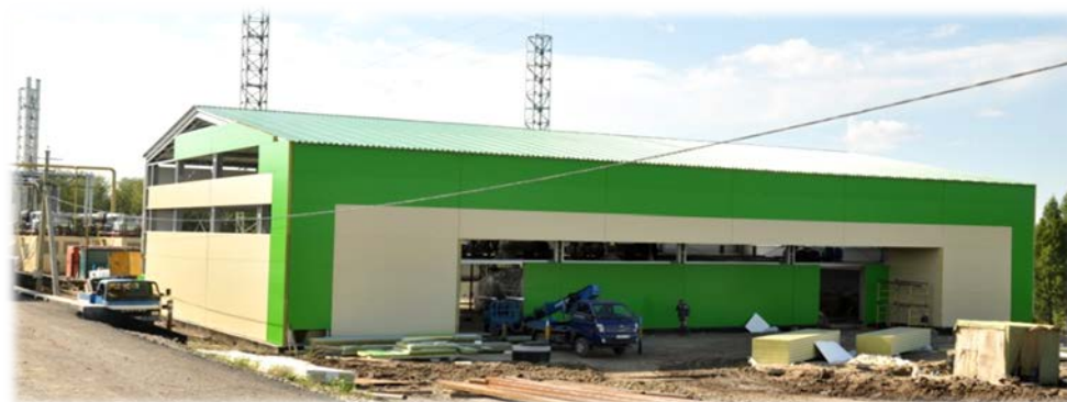
Монтаж стеновых панелей
