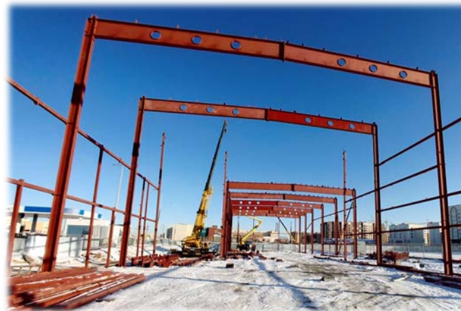
Монтаж каркаса здания
