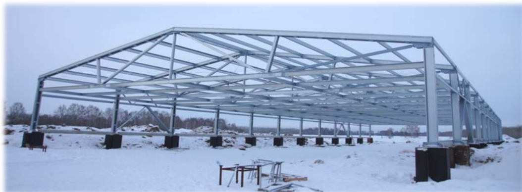
Монтаж каркаса Свинокомплекса
