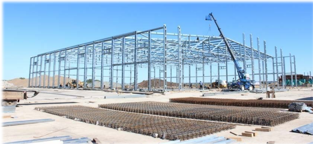
Монтаж каркаса здания
