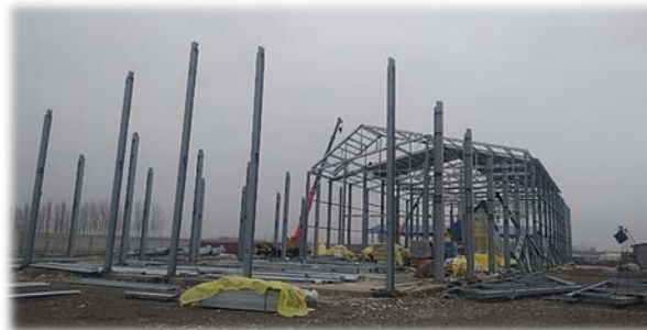
Монтаж каркаса здания
