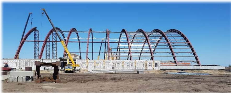
Пространственная схема каркаса
