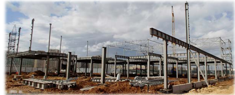
Монтаж каркаса здания
