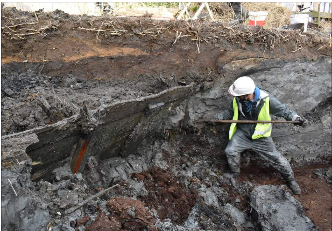
Afb. 4.1 De beschoeiing van de verlengde Skilsloot wordt vrijgelegd.
