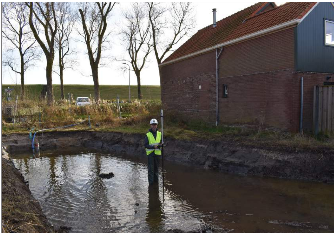
Afb. 3.1 Het gesaneerde deel wordt leeggepompt en ingemeten.
