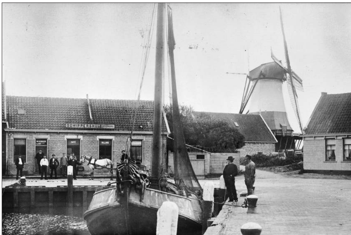
Afb. 5.111 De visserskotter de Twee Gebroeders (TX 54) in de haven van Oudeschild met café het Schippershuis en de stellingmolen de Traanroeier op de achtergrond. Helaas is de stootwil aan de zijkant van de boot net niet in beeld, aangezien er een meerpaal voor staat. Foto uit 1925 (collectie: Rijksdienst voor het Cultureel Erfgoed, documentnr. 195.969).
