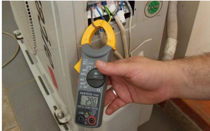
Resim 3.3: Pens ampermetreyle akım ölçümü
