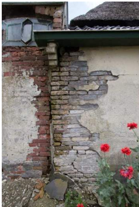
Afbeelding: Links verschillende soorten baksteen in de achtergevel van het pand. Rechts een negentiende-eeuws deurkozijn met bovenlicht, mogelijk afkomstig uit een oudere voorgevel van het pand.
