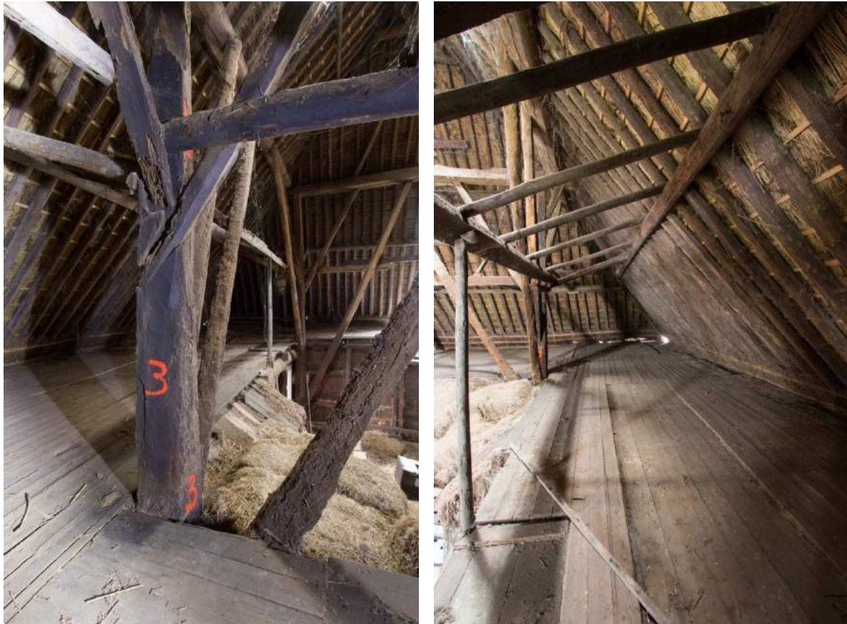
Afbeeldingen: Links één van de stijlen met daarop de gespijkerde aansluitingen van schoren. Rechts de wijze waarop een gording tegen doorbuiging is gezekerd.
