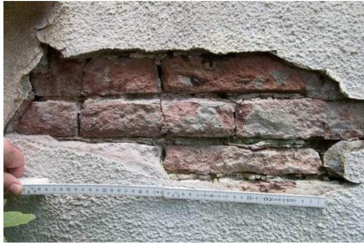
Afbeeldingen: Links zettingsscheur als gevolg van faseverschil tussen voorgevel en linker zijgevel van het gebouw. Rechts handgevormde bakstenen (globaal vóór 1850) in de linker zijgevel van het pand.
