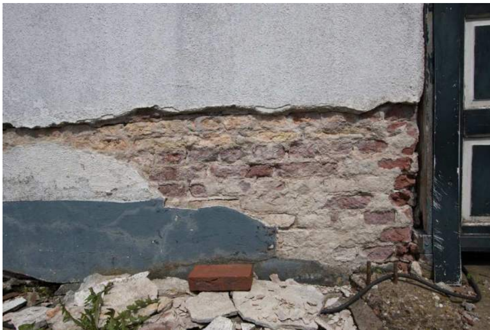
Afbeelding: Ten minste drie verschillende soorten bakstenen in de linker zijgevel ter plaatse van de deur naar de stal.
