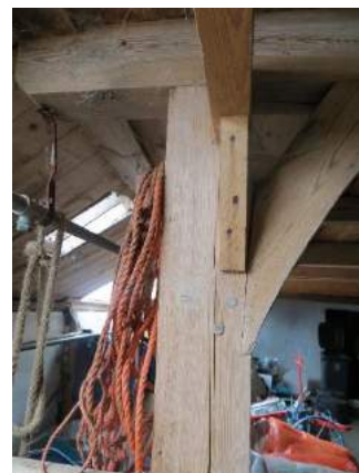
De koepalen hebben een korbeel met gepende houtverbinding
