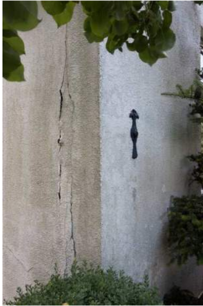
Afbeeldingen: Links zettingsscheur als gevolg van faseverschil tussen voorgevel en linker zijgevel van het gebouw. Rechts handgevormde bakstenen (globaal vóór 1850) in de linker zijgevel van het pand.
