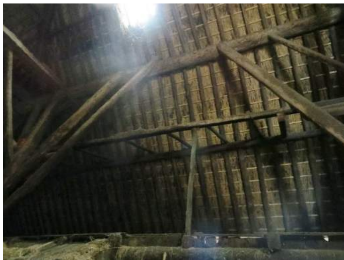
verbindingsjuk tussen de beide vierkantsgebinten met twee later toegevoegde zwingen (aan de noordkant)
