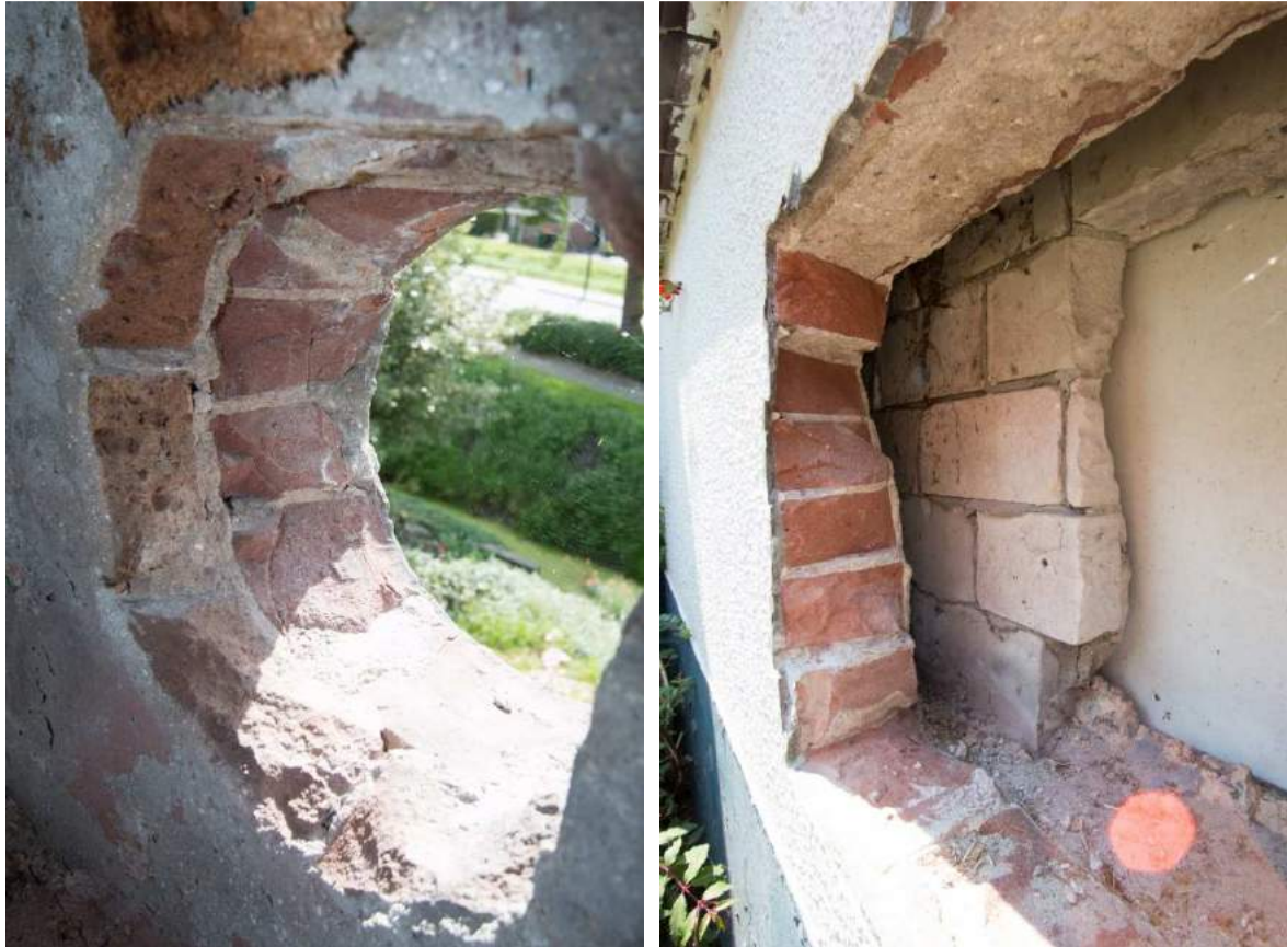
Afbeeldingen: Links de voorgeveltop met binnen hergebruikte stenen in een klamp en buiten machinaal gevormde bakstenen. Rechts een gat in de gevel van de keuken met louter modernere bouwmaterialen.
