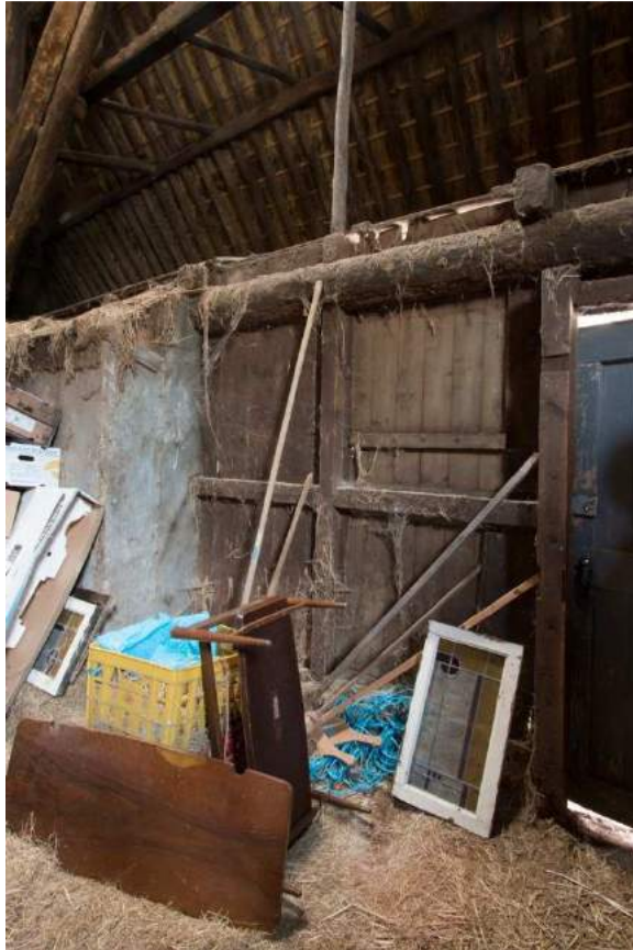
Afbeeldingen: Links een vermoedelijk achttiende- of negentiende-eeuwse wand tussen hooiplaats en stal. Rechts de stal met een constructie die niet ouder zal zijn dan de wand tussen stal en hoorplaats.
