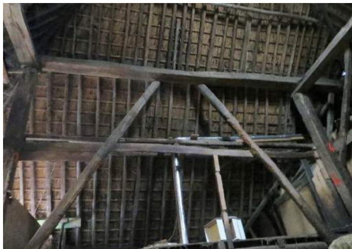
verbindingsjuk tussen de beide vierkantsgebinten met enkele zwingen (aan de zuidkant)
