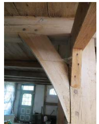
De koepalen hebben een korbeel met gepende houtverbinding
