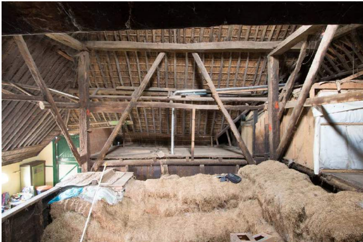
Afbeelding: Zicht op de dekbalk die over de beide gebinten is aangebracht. Daaronder/achter bevindt zich thans de keuken van het huis. Links zicht in de dars.
