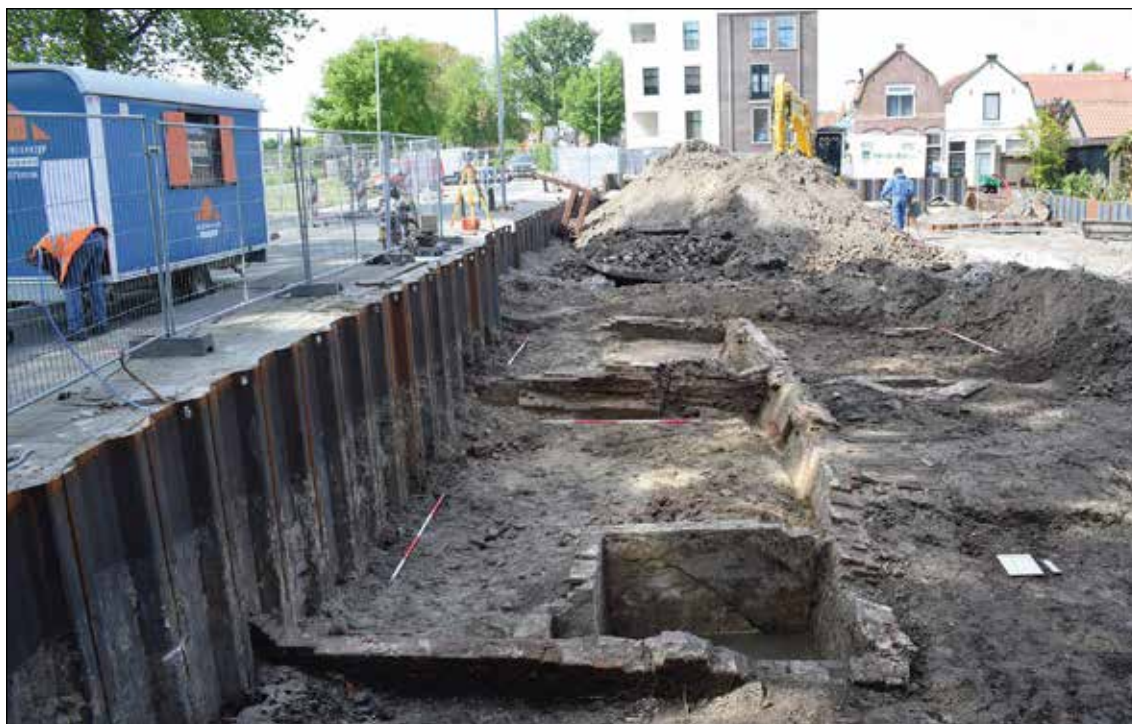
Afb 7.26 Het dijkhuis, kijkend richting het noorden. In de 17 de eeuw is het souterrain volgestort met zand en is een kleine voorraadkelder gemaakt.
