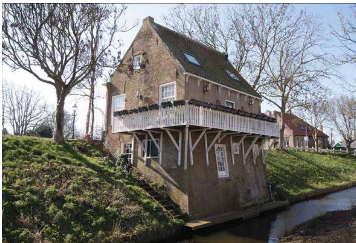
Afb 9.3 Dijkhuis Dijk 100 in Enkhuizen. De bouw op een dijktalud leidt tot een groot hoogteverschil tussen de voor- en achterzijde van het huis.
