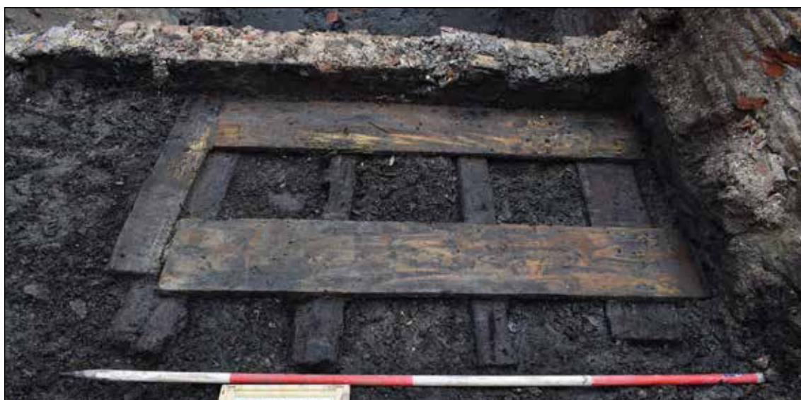
Afb 6.92 De fundering van de waterkelder: een houten raamwerk.
