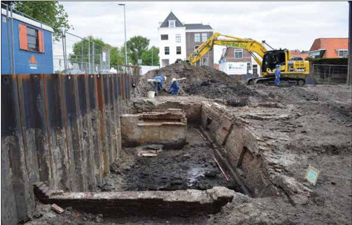
Afb 7.1 De opgraving kijkend richting het noorden, met de muren van het dijkhuis dat eind 16 de eeuw is gebouwd.
