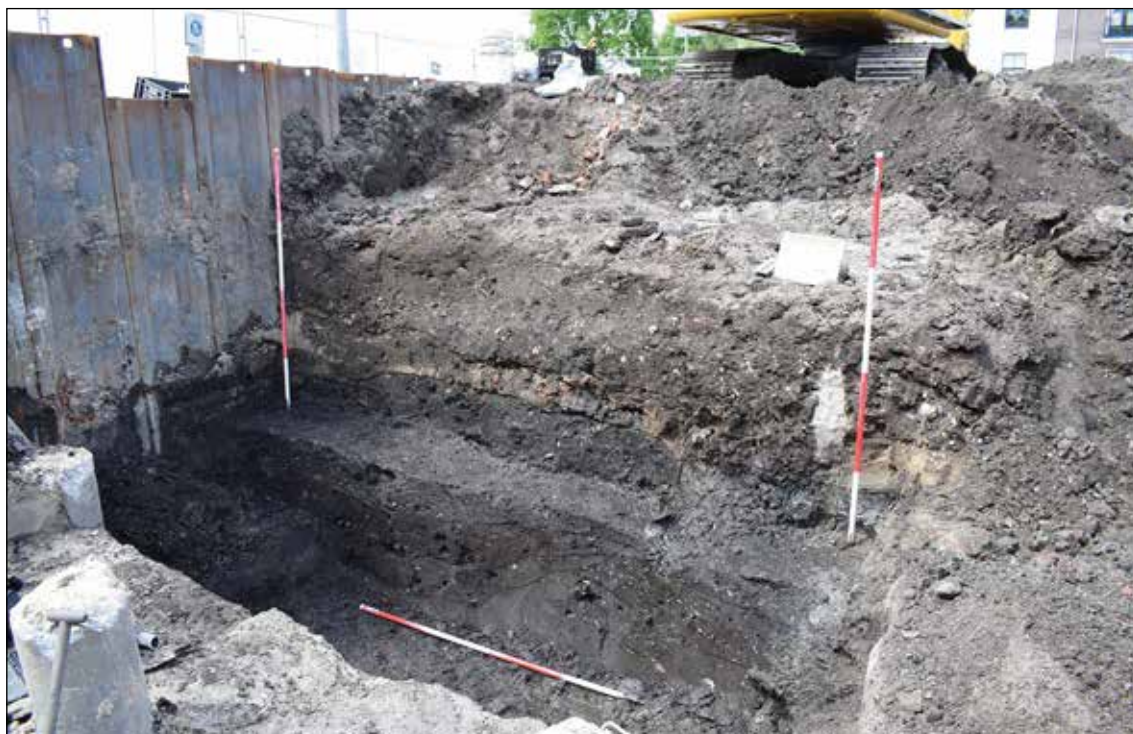
Afb 4.2 In het noordprofiel van werkput 7 bevinden zich dikke lagen met afval en puin, die samenhangen met de dijkhuizen die hier hebben gestaan.
