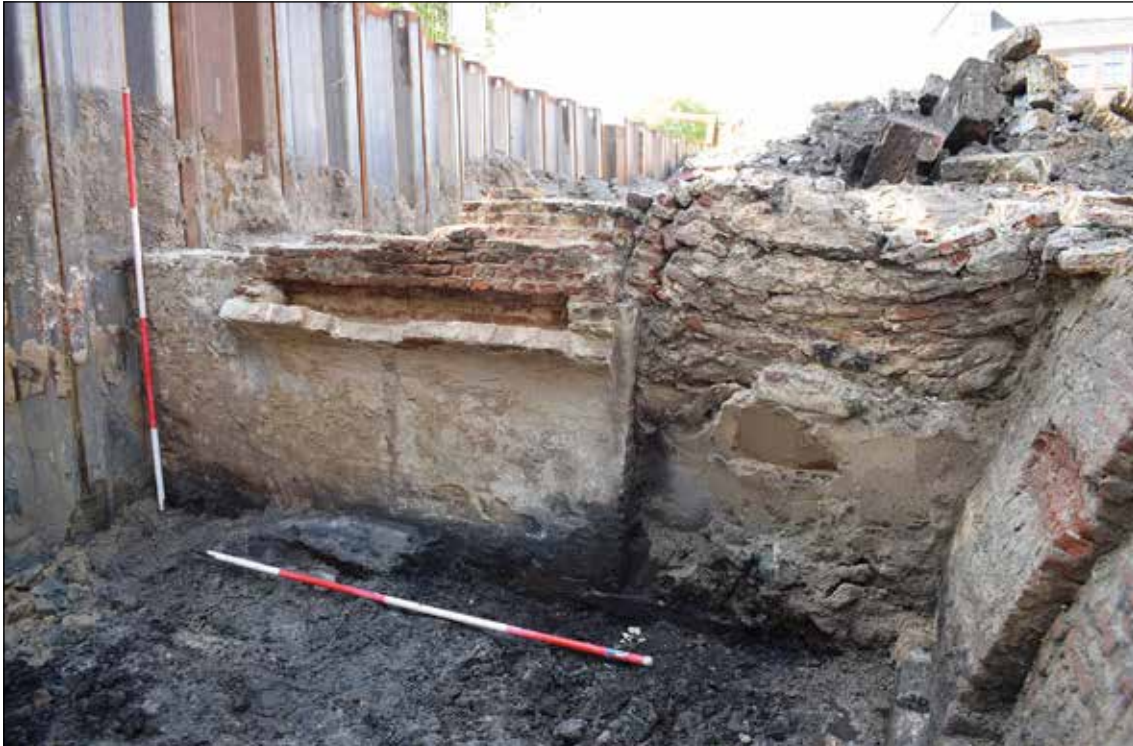
Afb 7.6 De binnenmuur met aanzet van een boog, ter ondersteuning van de haardplaats en schoorsteen op de eerste verdieping.
