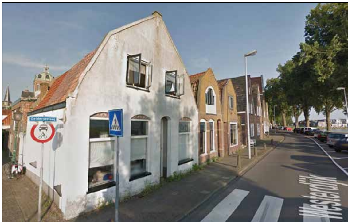
Afb 1.3 De bebouwing die is gesloopt om plaats te maken voor nieuwbouw (bron: Google Streetview)
