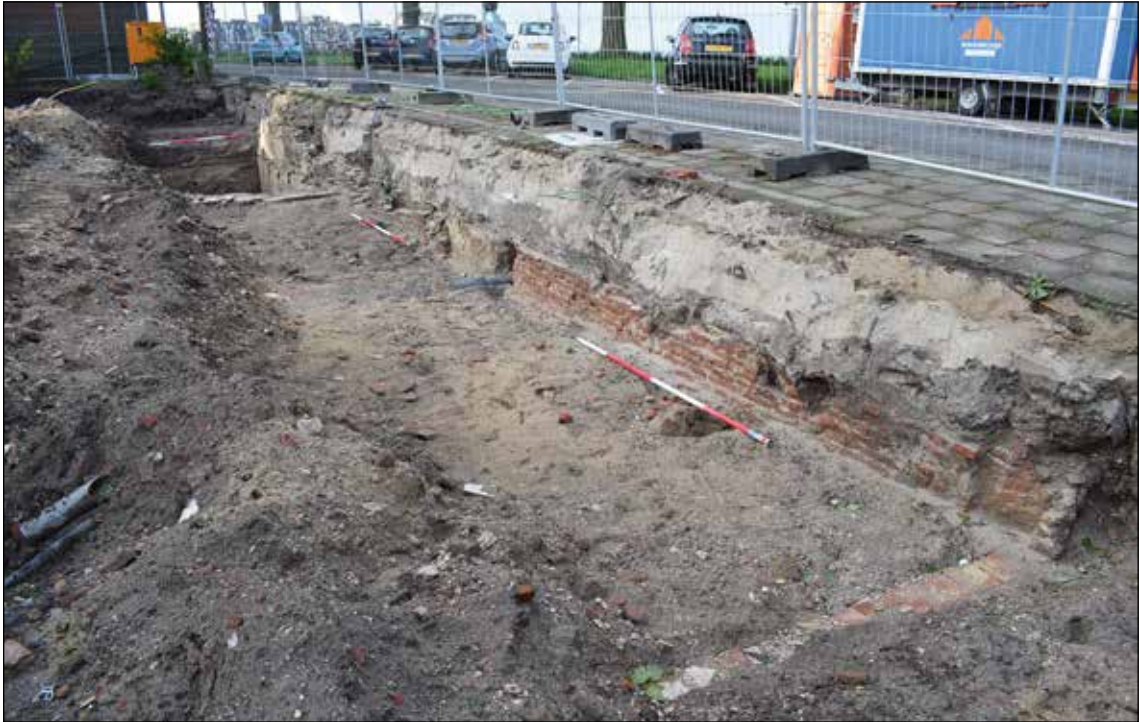
Afb 6.8A De westmuur van het huis is voorafgaand aan het slaan van de damwand gedocumenteerd.
