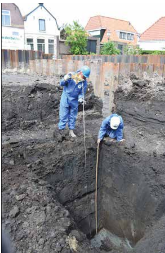
Afb 4.1 Op het terrein was een metersdikke dijkophoging van veen en klei aanwezig. Geheel onderin de lichtgrijze natuurlijke bodem en daarop een restant van een veenlaag.
