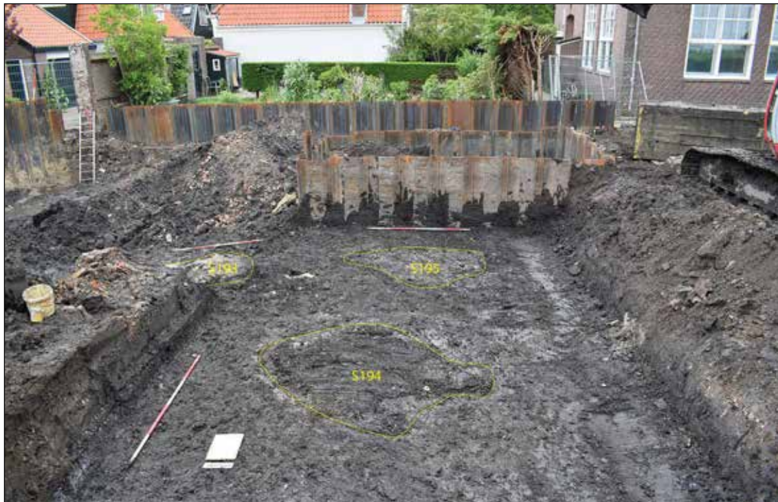
Afb 5.6 Opgraving van perceel 1, kijkend richting het oosten. In het vlak zijn grote kuilen te zien, die mogelijk de uitgebroken poeren van de standerdmolen betreffen.
