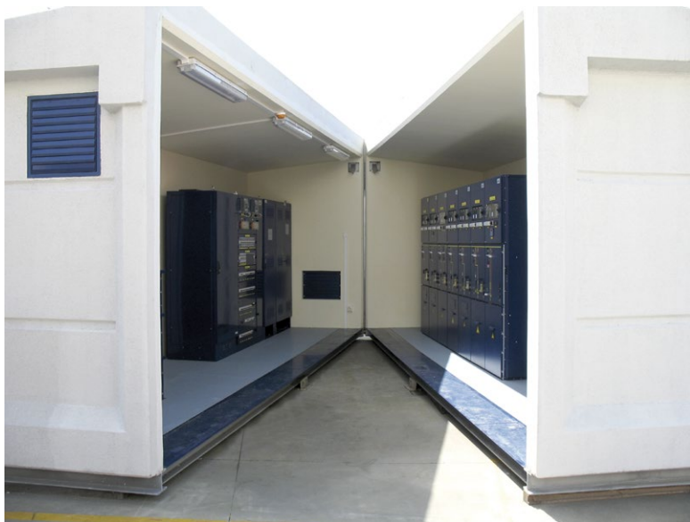
Vista interior edificio A35
