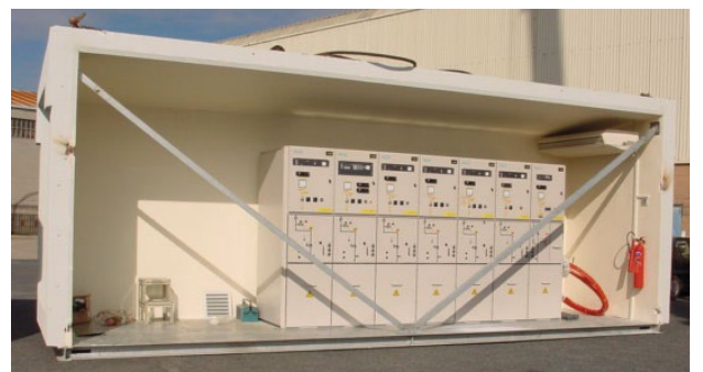
Preparación para transporte edificio A35
