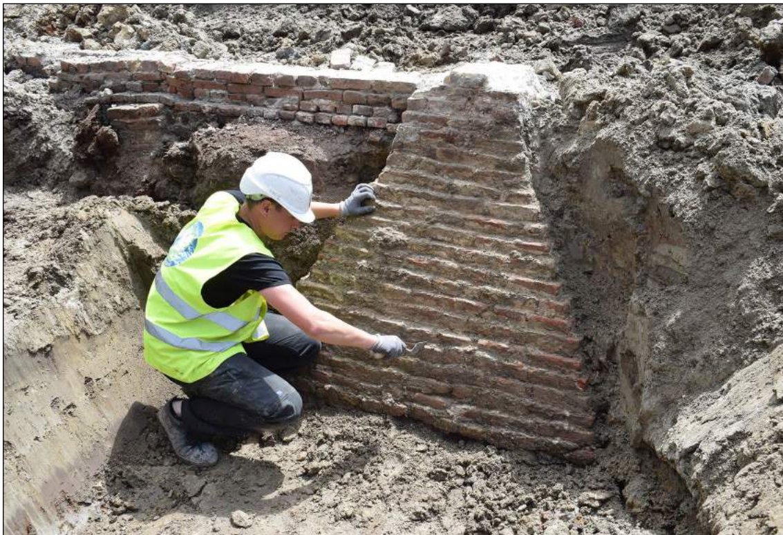
Afb. 55. Vierkantpoer van een Westfriese stolpboerderij uit Schellinkhout. De versnijdende zool zorgt voor genoeg draagkracht om het vierkant te dragen.
