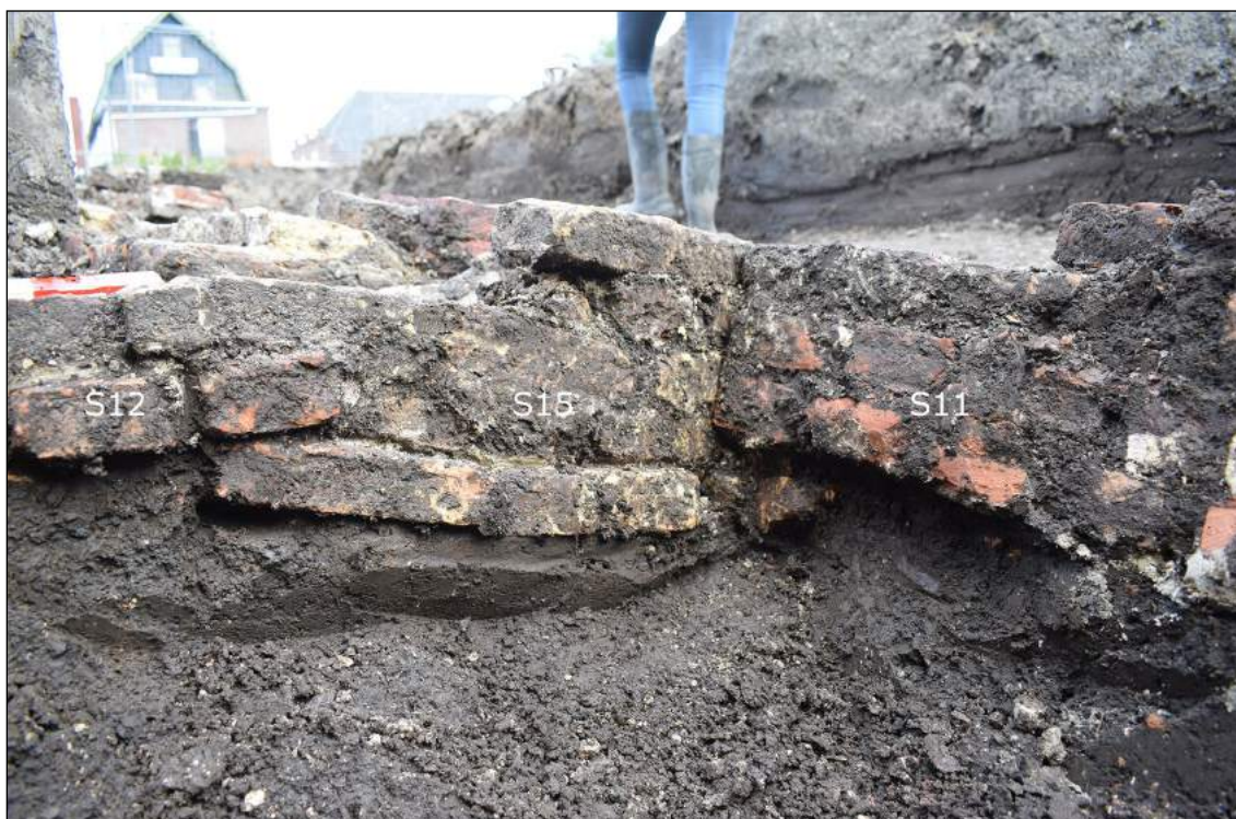
Afb. 53. Detailopname van de achtergevel van de 18 de -eeuwse boerderij. Hierop is te zien dat de nieuwe achtergevel (S12) over de 17 de -eeuwse oostgevel (S15) is gebouwd. Muur S11 dateert waarschijnlijk uit een latere fase.
