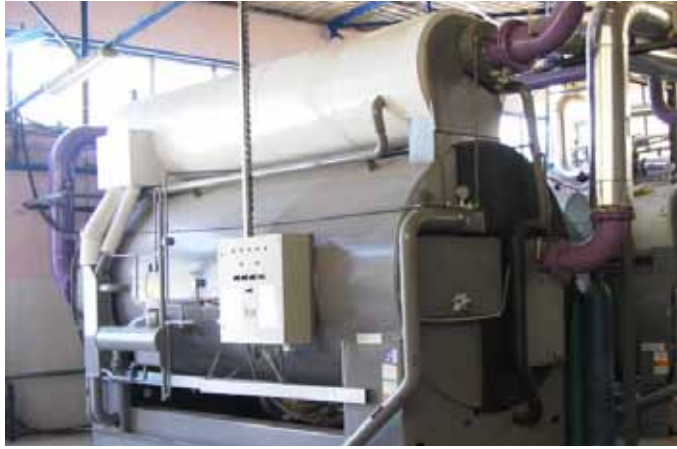
Resim 2- Carrier 16 JLR Tek etkili, absorpsiyonlu su soğutma gurubu [6]
