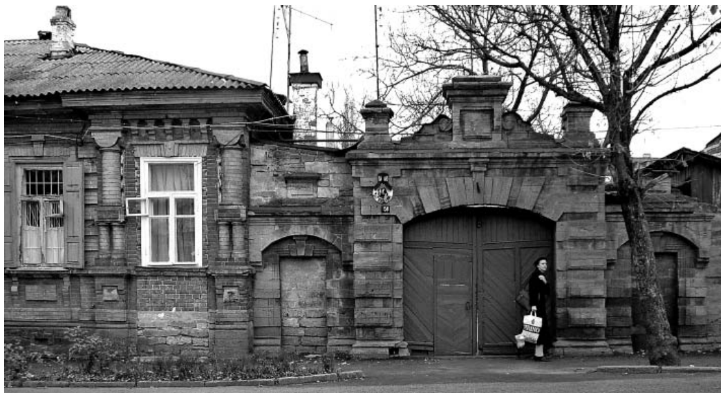
Типичный ставропольский дом по улице Калинина, 44, из двухцветного кирпича, с характерными для строений нашего города вычурными стилизованными колоннами. Вход в форме портала выполнен из ставропольского рыхлого ракушечника, с удачным использованием его мягкой пышной фактуры.
