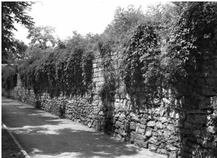
Каменная стена на проспекте К. Маркса.
