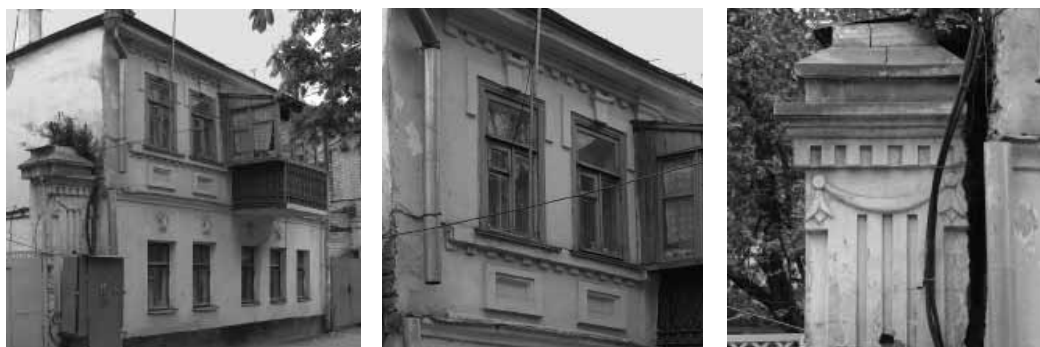
Каменные «сухарики» над окнами, под окнами, в верхней части воротного столба. Проспект К. Маркса, 40.
