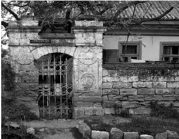
Забор из глыб ракушечника, массивная каменная арка делают дом ставропольца похожим на крепость. Улица Ставропольская, 16.
