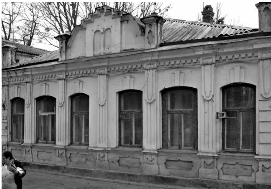
Прочные каменные дома из известняка-ракушечника в один и два этажа активно строились в XIX веке. Архаическая символика — непрменный атрибут декоративной отделки фасада. 1. Проспект К. Маркса, 60. 2. Проспект К. Маркса, 25.
