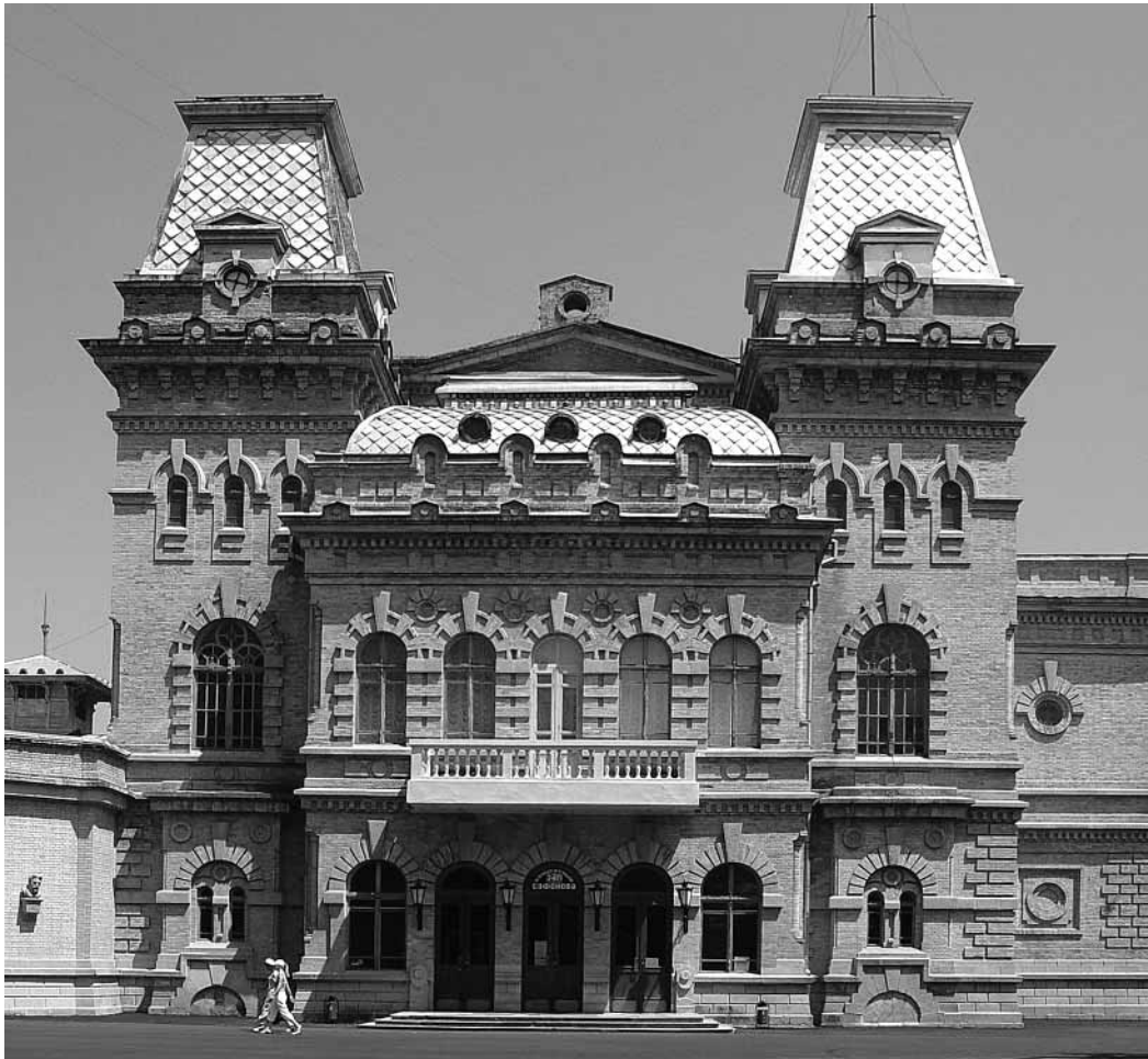
Филармония на КМВ. Главный фасад.
