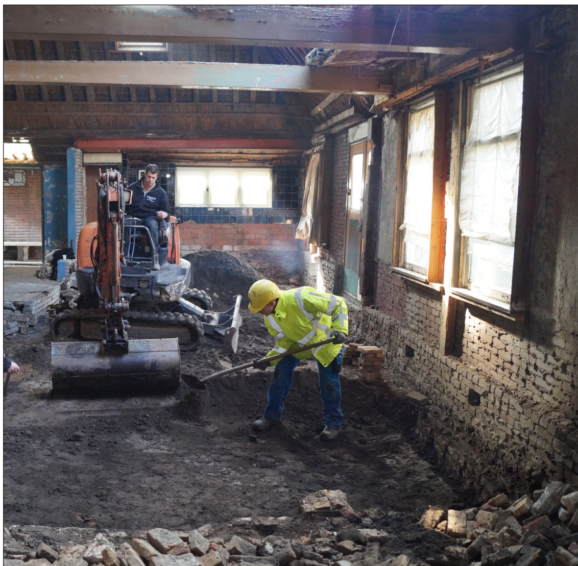
Afb. 25 De inpandige opgraving van de stolpboerderij Dorpsstraat 210 in Zwaag in volle gang, augustus 2014.
