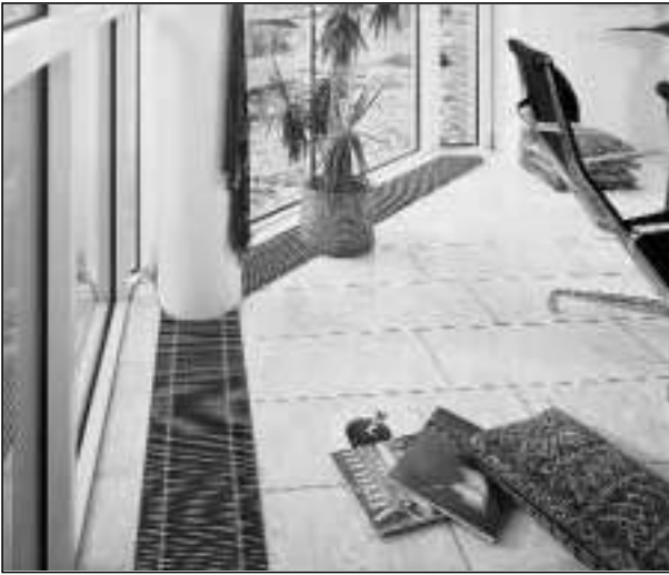
Şekil 6.11/ DÖŞEME TİPİ KONVEKTÖR UYGULAMASI
