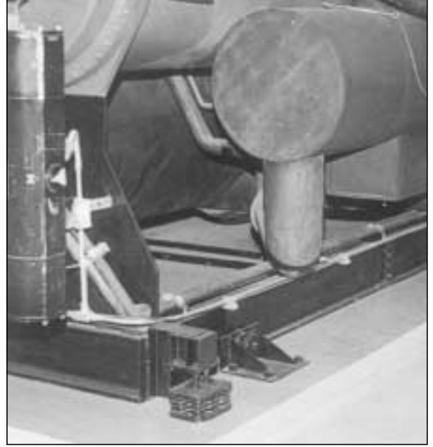
Şekil 13.6/ SİSMİK SINIRLAYICI HALİNDE ZARAR YOK
