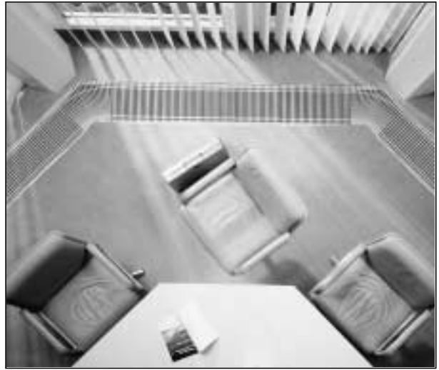
Şekil 6.12/ DÖŞEME TİPİ KONVEKTÖR UYGULAMASI
