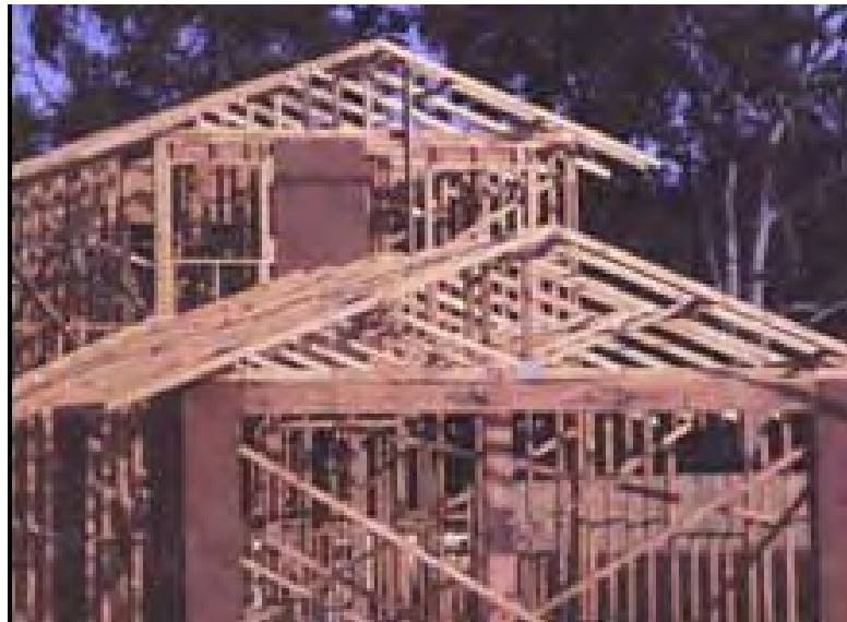
Resim-6 Ahşap Ev İskeleti
