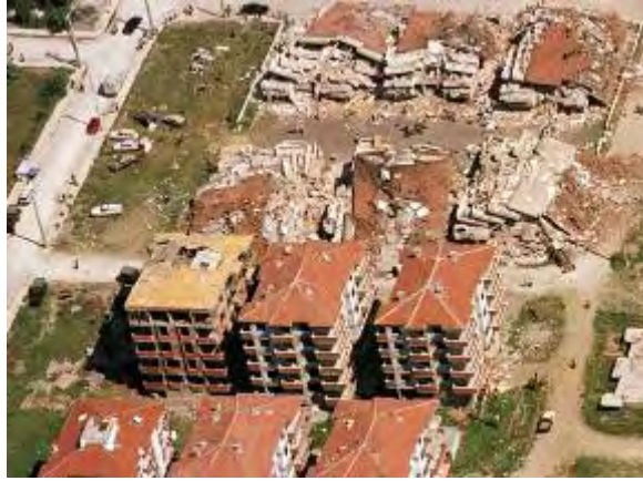
Resim-14 Aynı Zeminde Farklı Yapıların Dayanaklılığını Gösteren Bir Kesit
