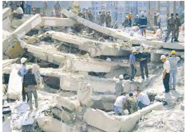
Resim-20 Yamyassı Çöken Bina Enkazından
